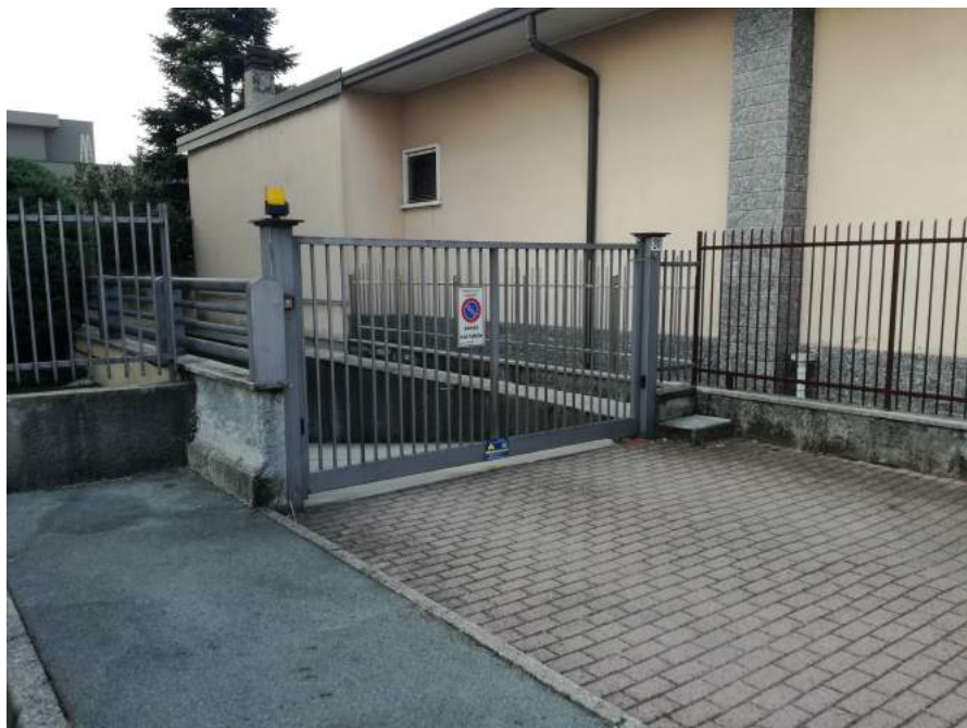
Foto 6,7 – vista cancelli d'entrata e giardino sul retro
