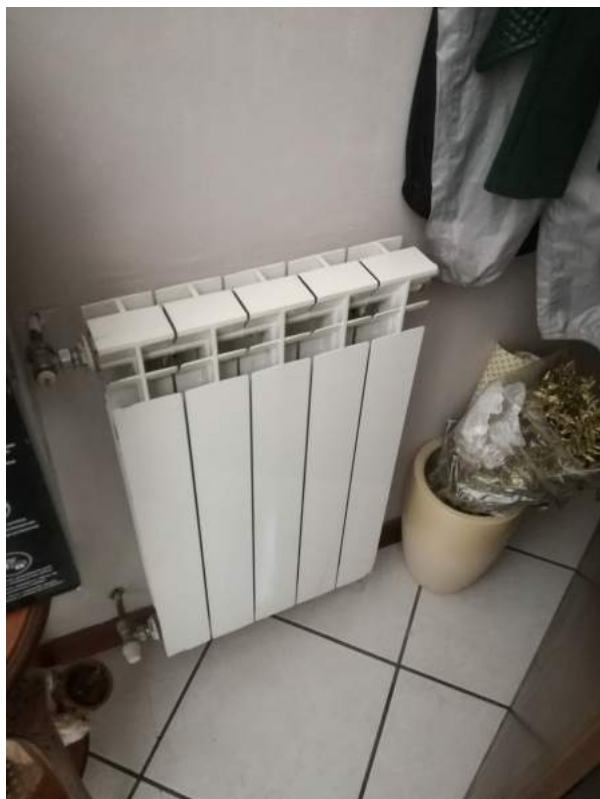
Foto 18,19 – radiatori tipo e caldaietta
