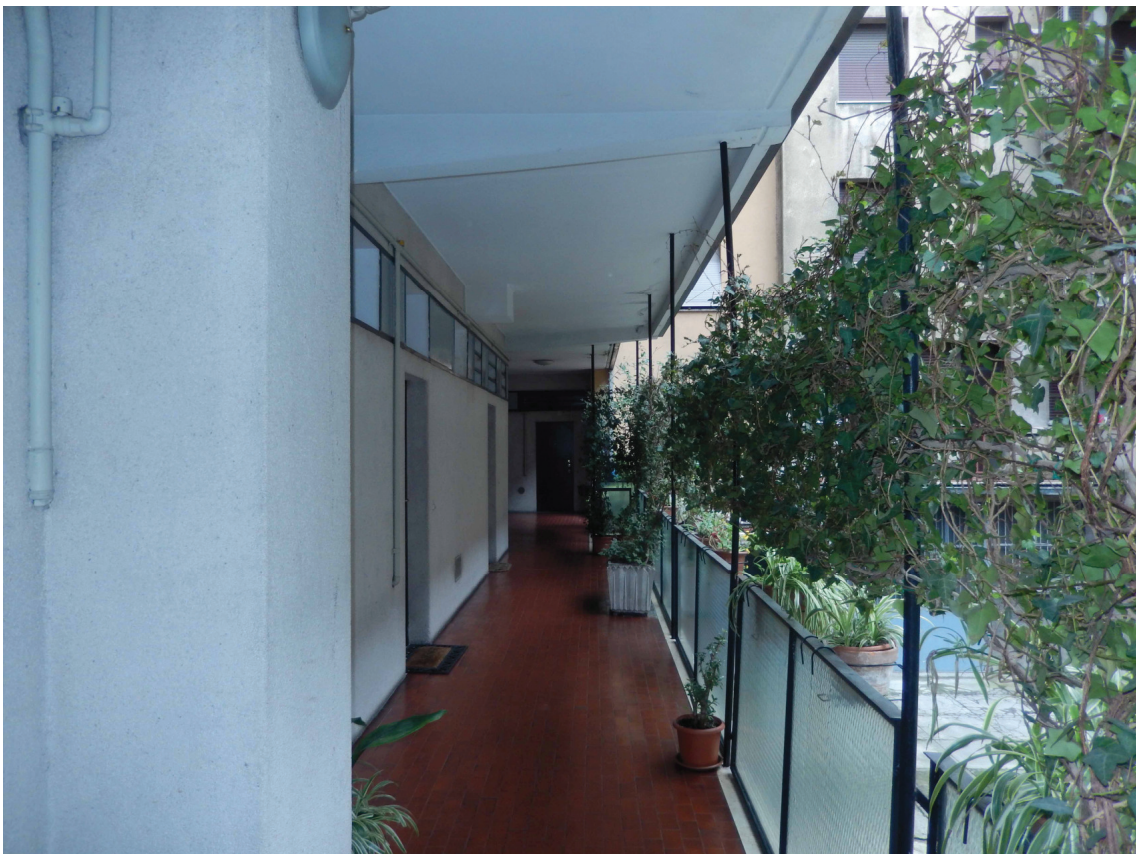
Foto 6 – Vista parziale del ballatoio comune che disimpegna le unità.
