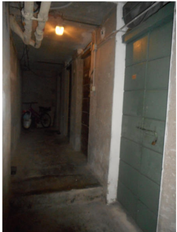
Vista del corridoio di accesso alle cantine
