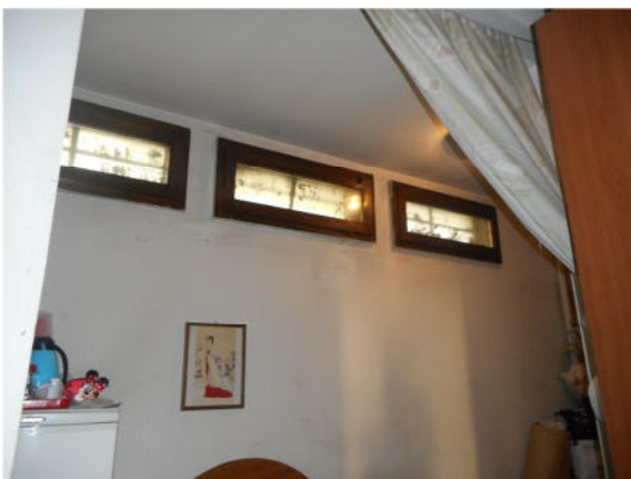
Vista delle finestre alte poste nel corridoio
