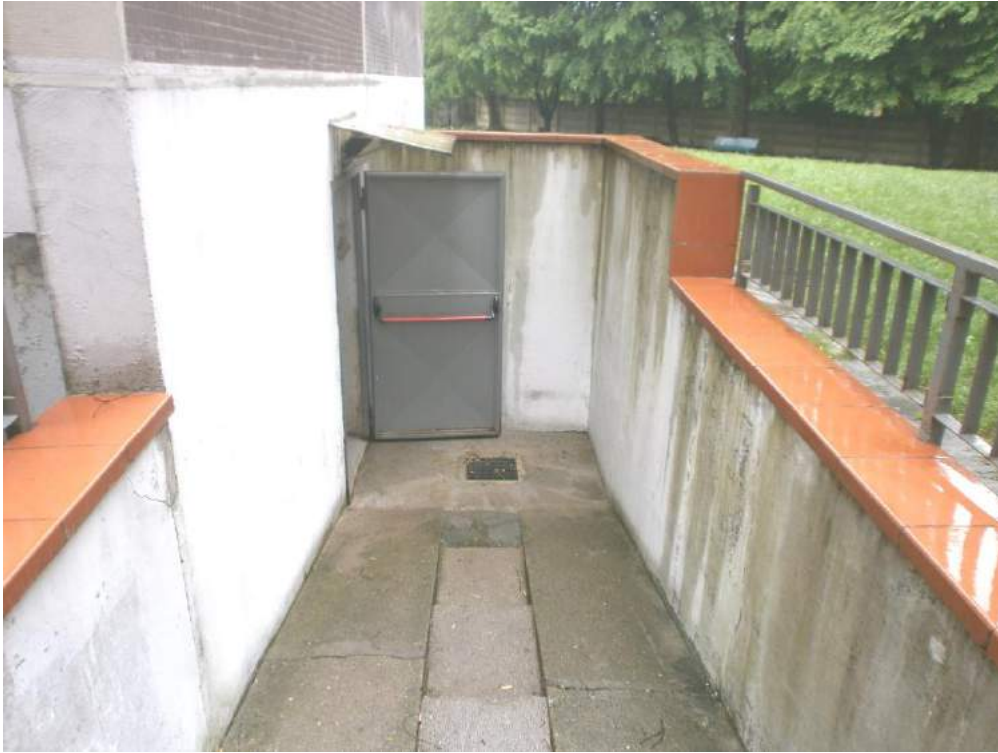
- FOTO 22 - ACCESSO AL PIANO INTERRATO ADIBITO A CANTINE -
