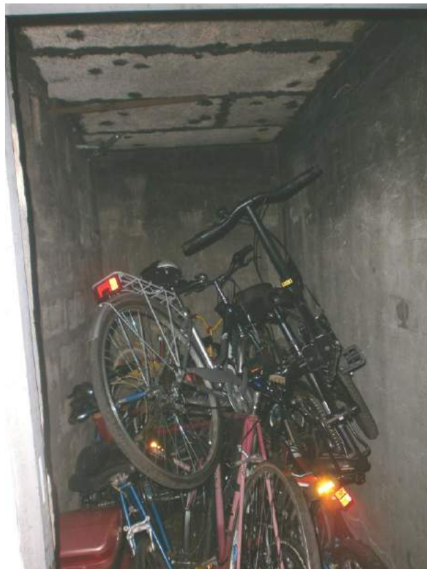
- FOTO 26 - INTERNO DELLA CANTINA -
