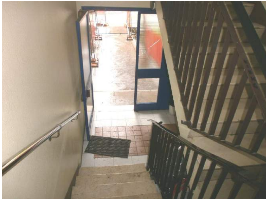
– FOTO 6 – SCALE CONDOMINIALI –
