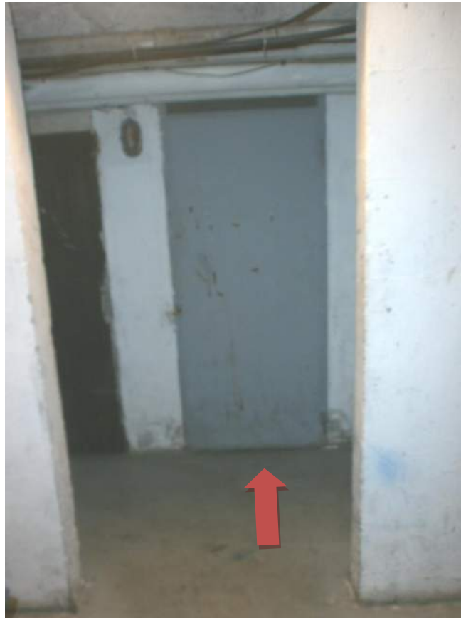
- FOTO 24 - CORRIDOIO COMUNE - IN EVIDENZA LA PORTA DELLA CANTINA -
