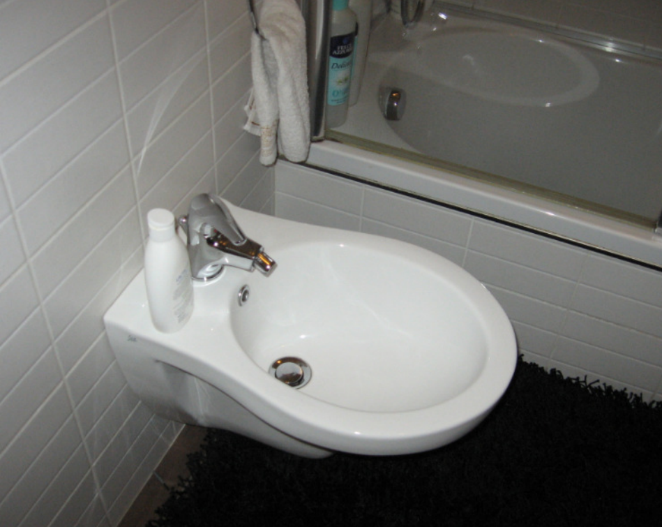
Particolare dei sanitari
