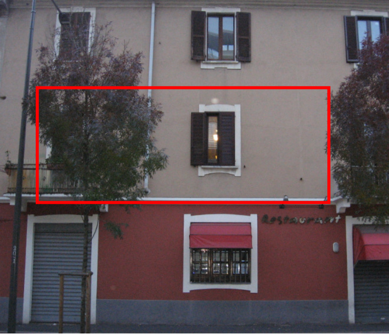
Affaccio su strada
