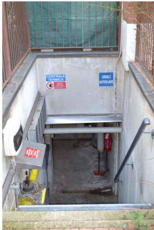
FOTO N. 17 – CENTRALE TERMICA CONDOMINIALE
