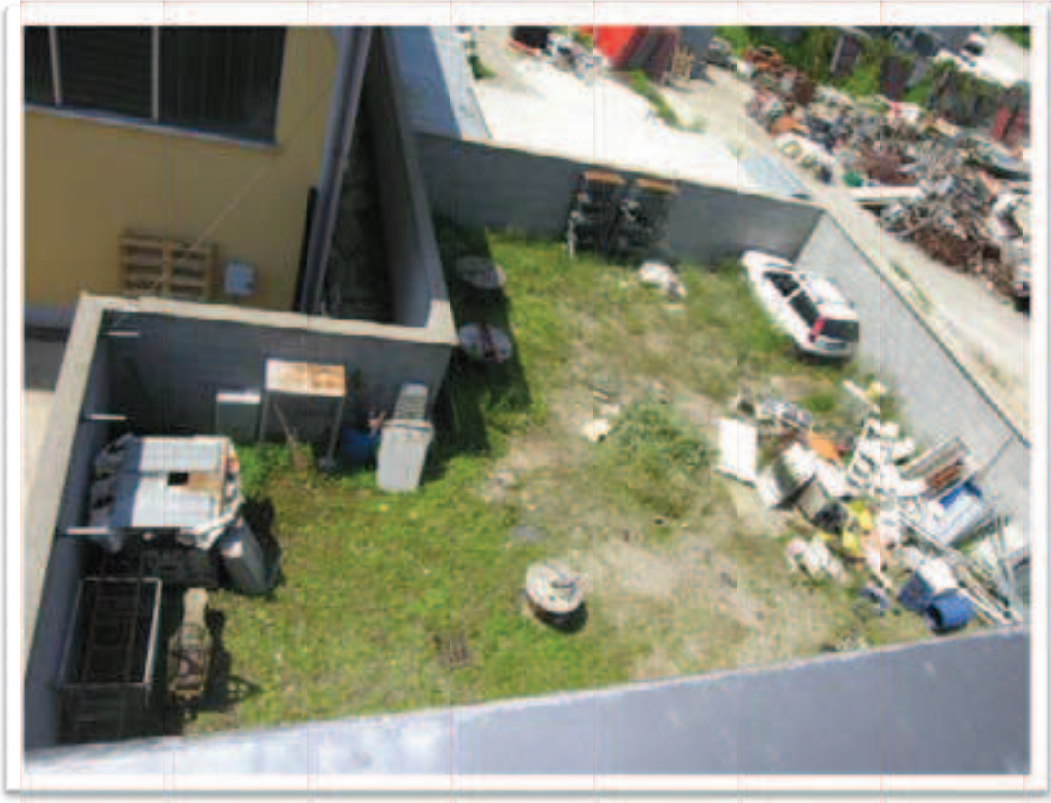
Vista del cortile al mappale 251 dall'alto e vista interna del capannone ( LOTTO n. 1 ).
