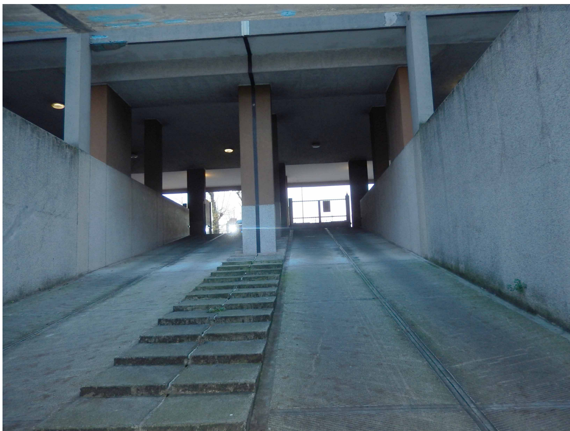
Foto 16 – La rampa carraia d'ingresso e di uscita.
