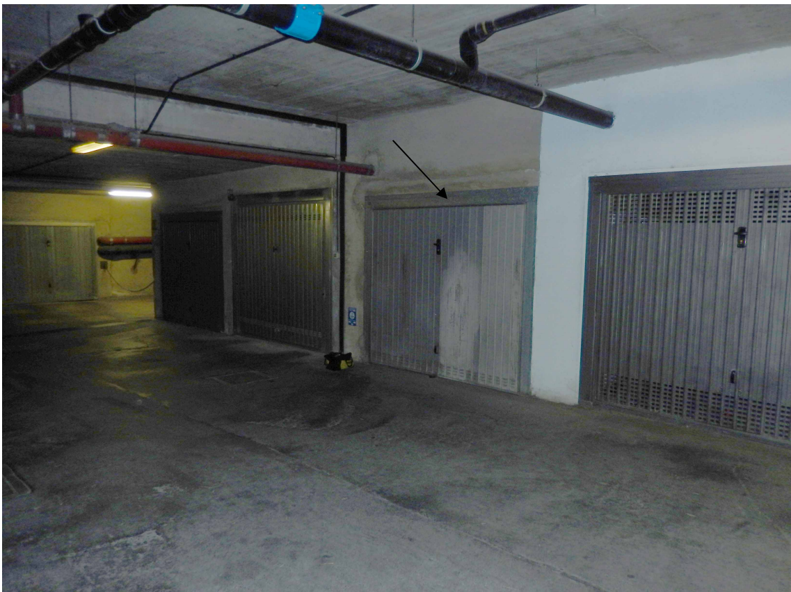
Foto 14 – Il box al piano interrato (indicato dalla freccia l'unità in esame).
