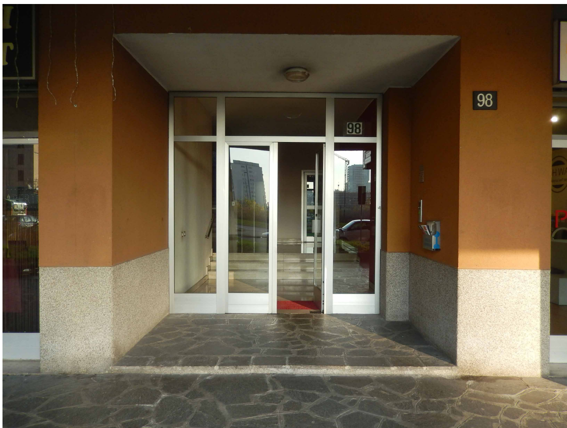
Foto 3 – Il portone di accesso al fabbricato.
