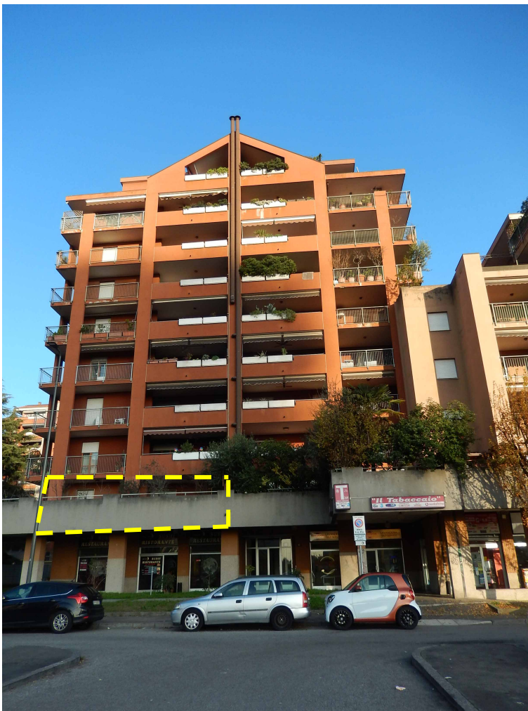
Foto 2 – La facciata del fabbricato. Evidenziata dal tratteggio l'unità in esame.
