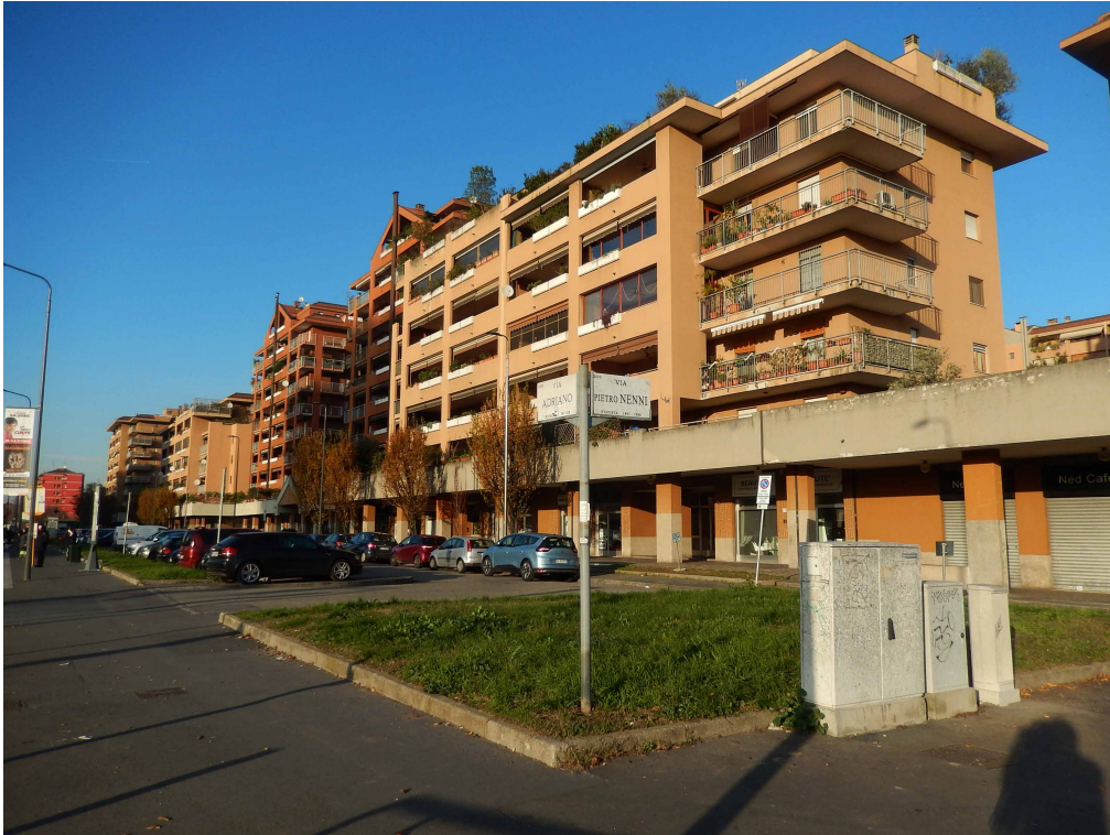
Foto 1 – Vista del complesso in esame.
