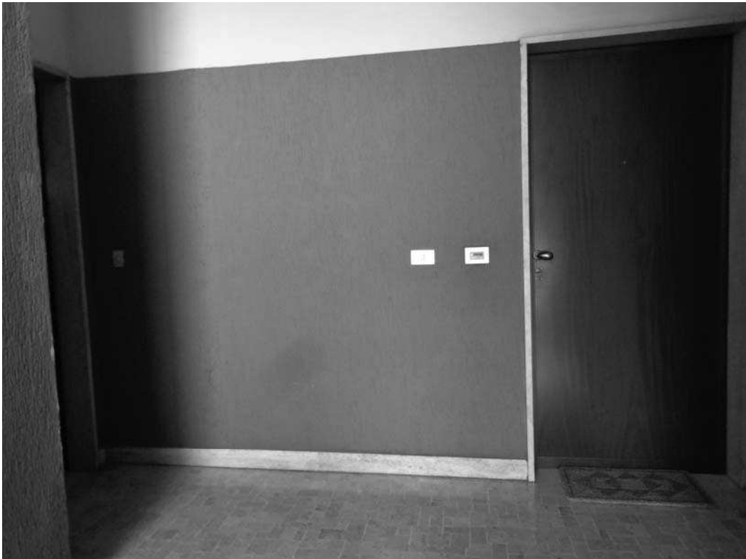
Immagine. 5. Pianerottolo comune di ingresso. La porta di ingresso all'appartamento è quella a sinistra.
