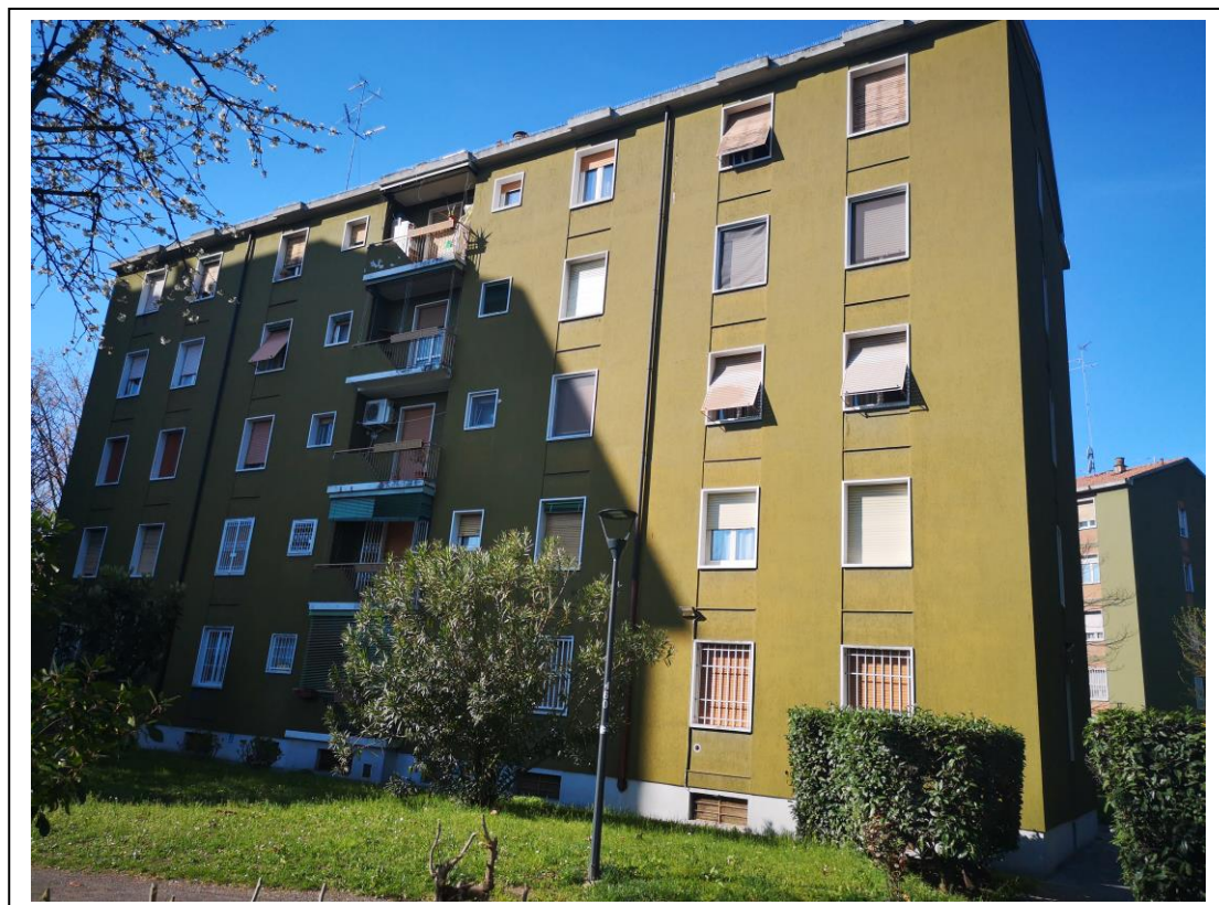
Fotografia n°4 – Vista del fronte secondario rivolto su giardino comune.
