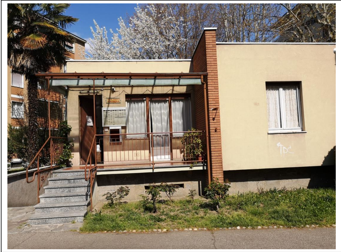
Fotografia n°1 – Vista del fabbricato destinato a portineria del complesso edilizio.
