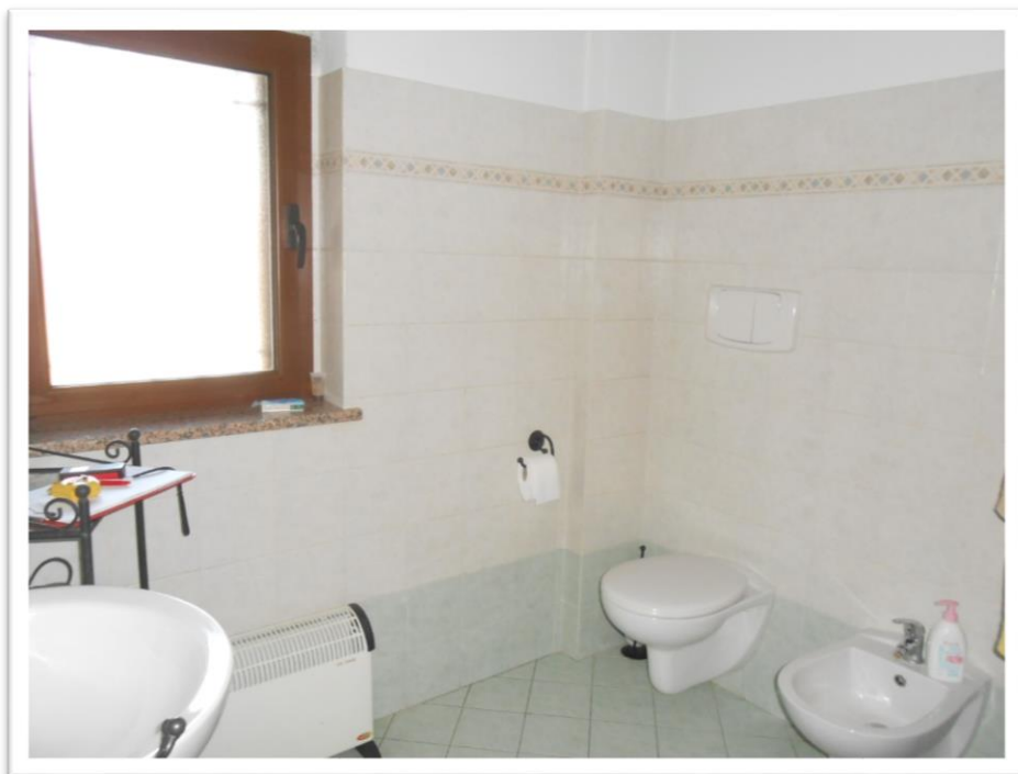
Foto 17 bagno del secondo piano
