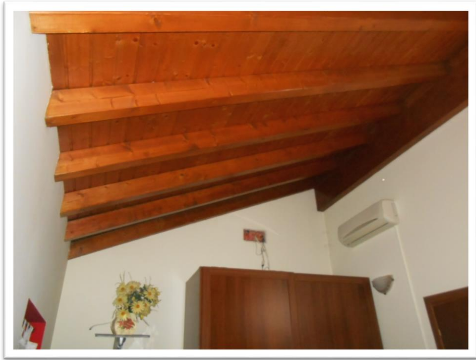
Foto 16 travi in legno del secondo piano
