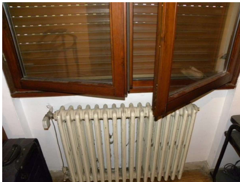
Dettaglio serramento e termosifoni
