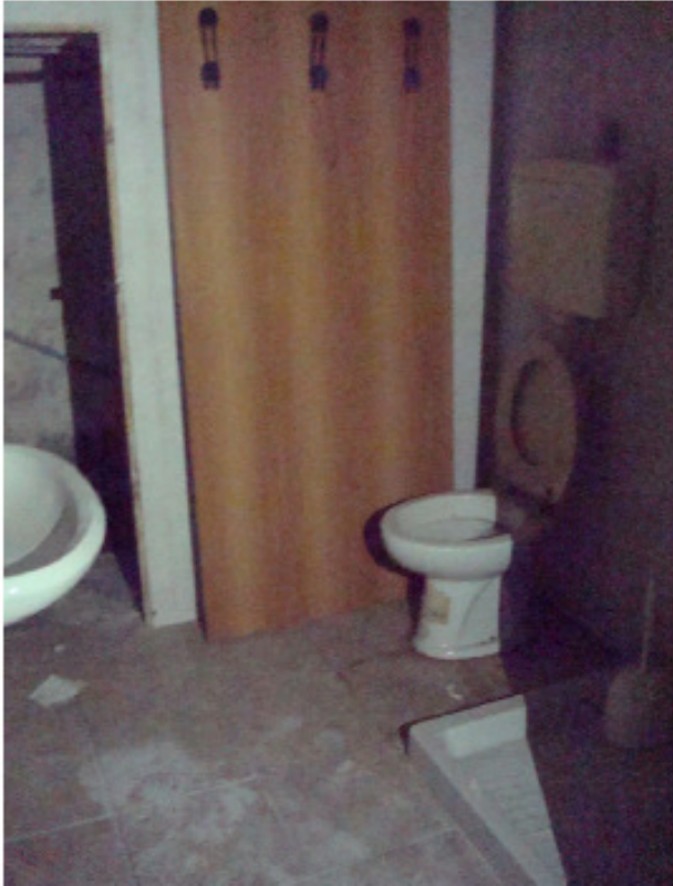
Particolare servizio igienico magazzino
