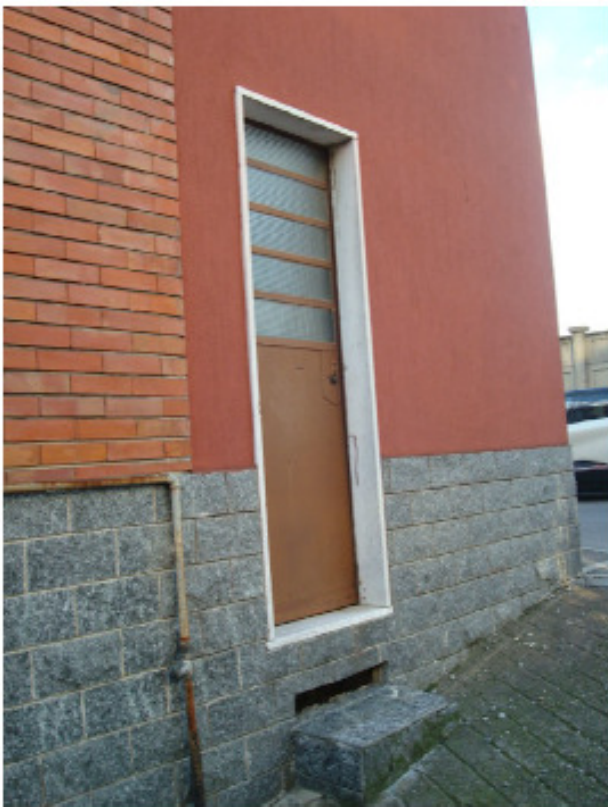
Ingresso locale WC piano terra.
