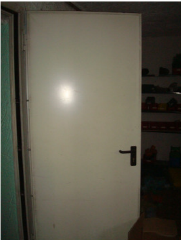
Particolare porte interne magazzino
