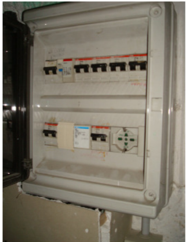
Quadro elettrico magazzino
