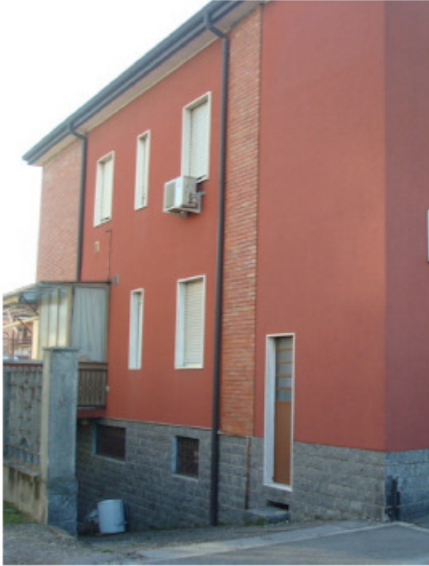
Via IV Novembre, 60 - visuale esterna
