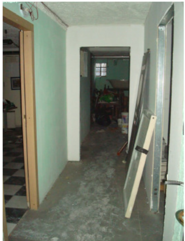
Disimpegno magazzino piano seminterrato
