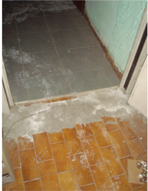
Particolare pavimentazione magazzino
