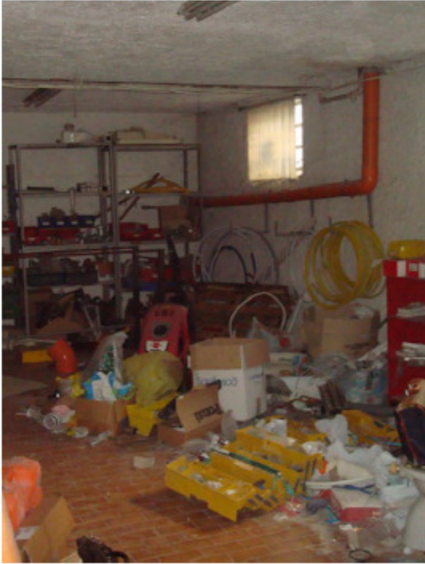
Particolare magazzino piano seminterrato
