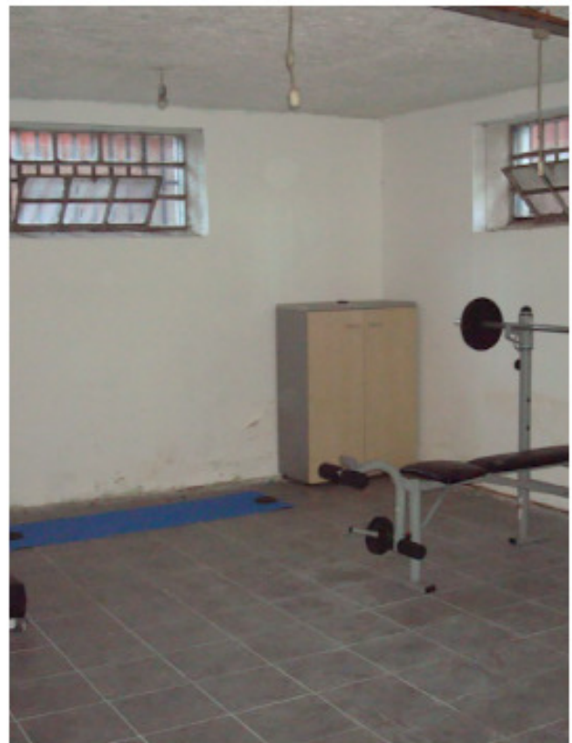
Particolare locali magazzino
