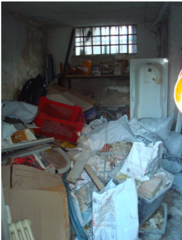
Particolare del BOX su. 703 al piano seminterrato
