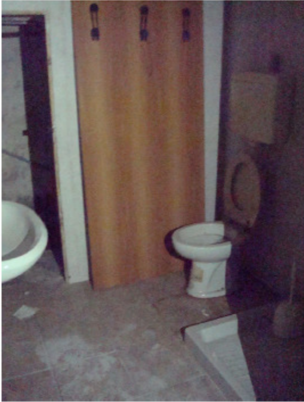
Particolare servizio igienico magazzino
