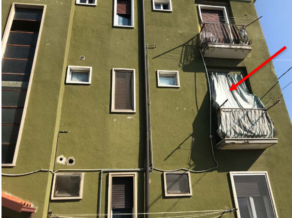
Viste prospettiche _ Foto _ 5
