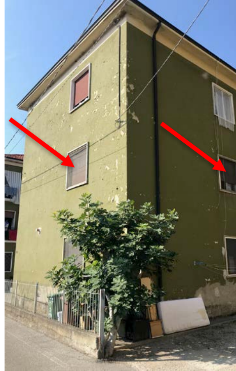
Viste prospettiche _ Foto _ 3-4
