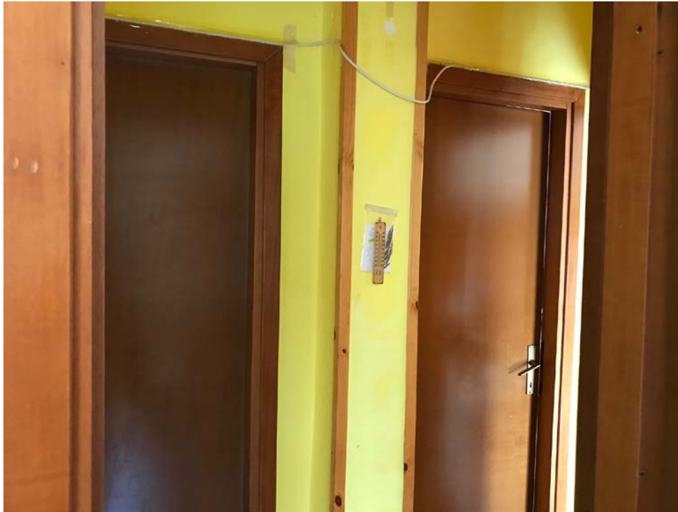
Particolare porte ingresso alle camere _ Foto _ 8
