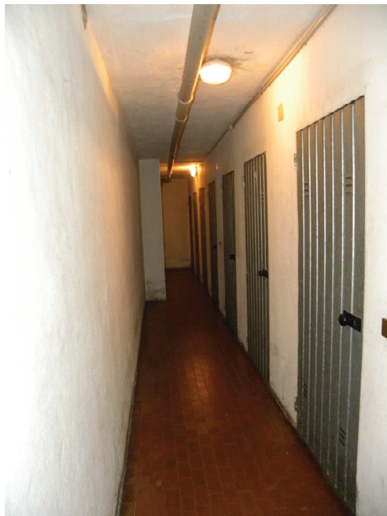
Parti Comuni corridoio cantine
