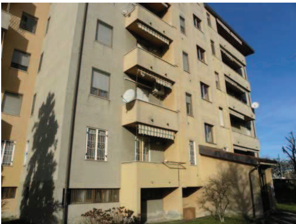
Vista Esterna del Fabbricato
