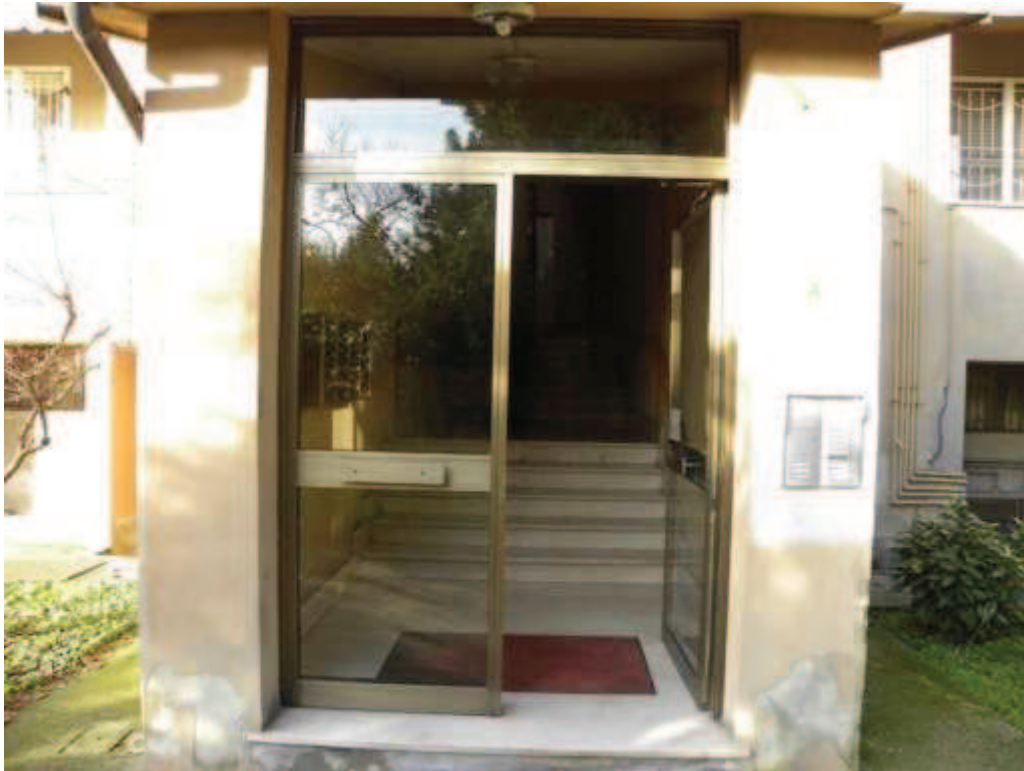
Portone di Ingresso del Fabbricato
