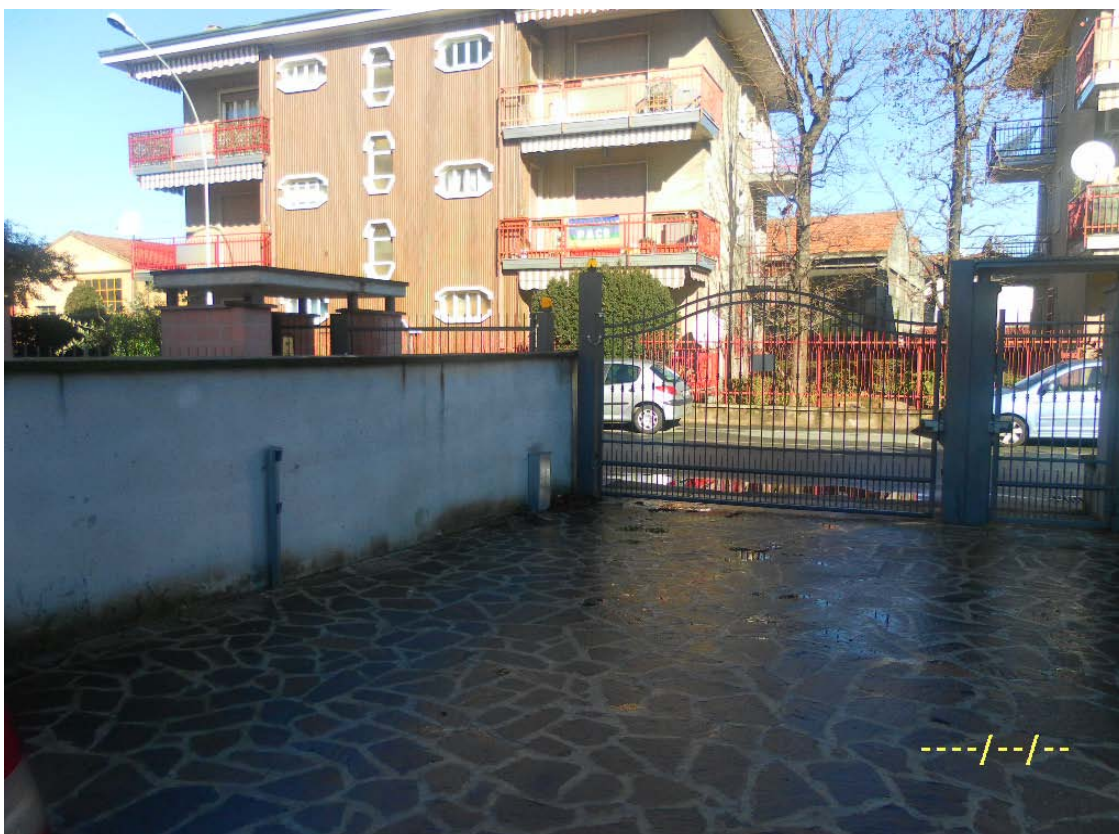
Foto n. 18: Ingresso carrabile da Via Sant'Ambrogio.
