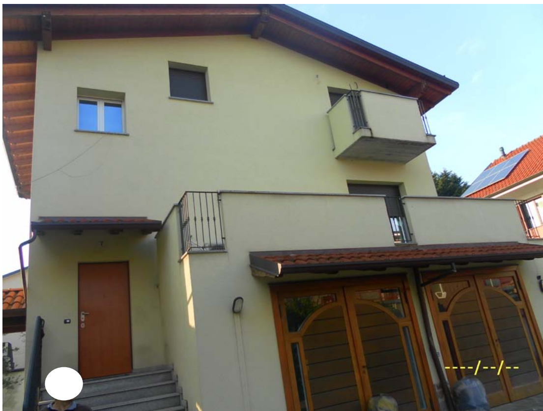
Foto n. 15: Vista prospetto principale.
