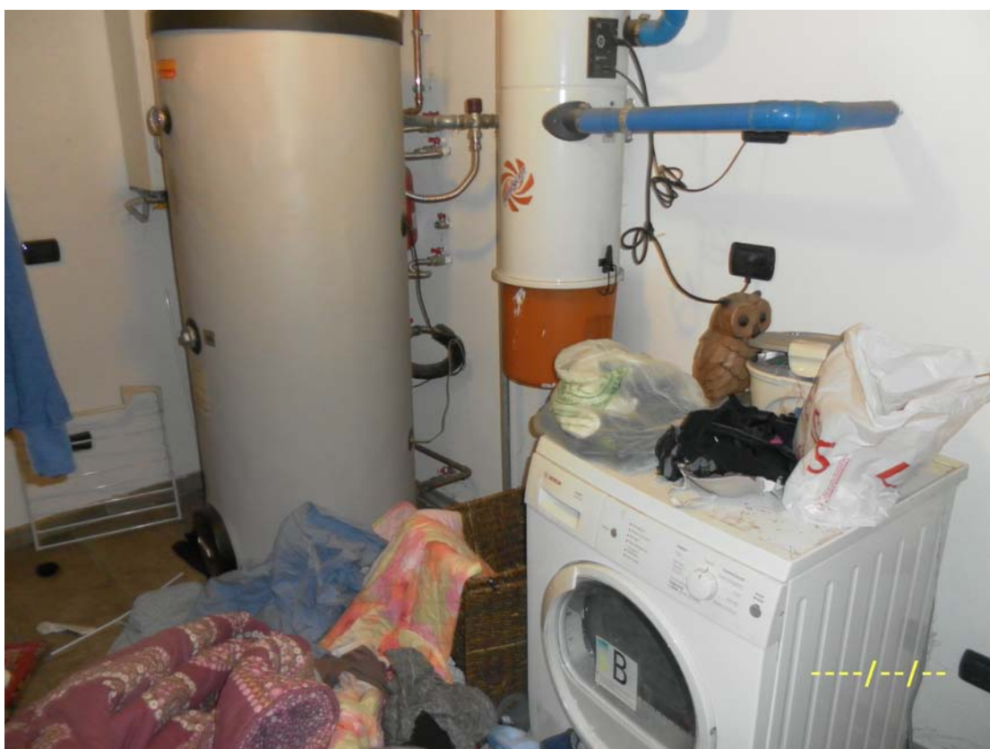
Foto n. 14: Locale tecnico - Piano Terra.
