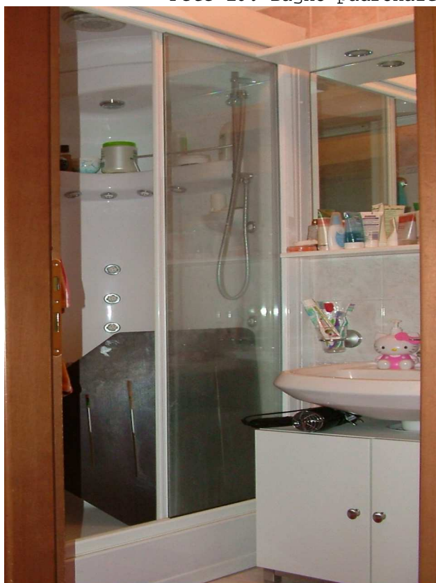
Foto 18. Bagno di servizio
