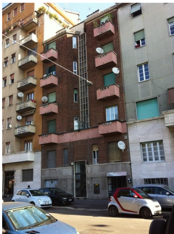
Vista dell'esterno da via Monte Generoso.
