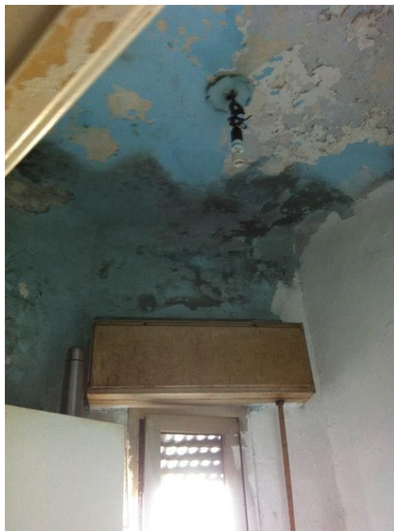
Vista del soffitto della cucina.
