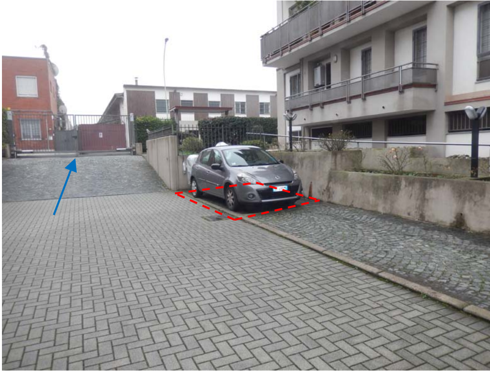
FOTO 27: Vista della posizione dell'unità pignorata, evidenziata dal tratteggio rosso. La freccia blu indica il cancello carrai che fornisce l'accesso dalla Via Piero della Francesca.
