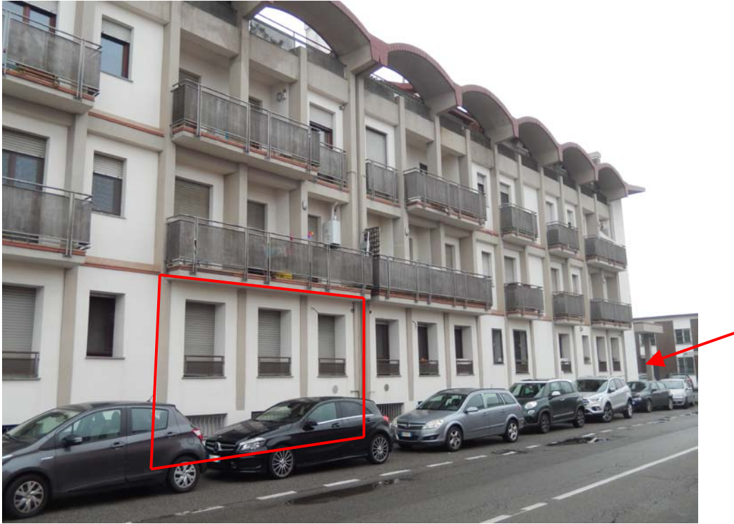
FOTO 3: Ulteriore vista dell'affaccio sulla Via Marconi dell'appartamento pignorato (evidenziato dal poligono rosso). La freccia indica la Via Piero della Francesca, da dove si accede alle unità in esame.
