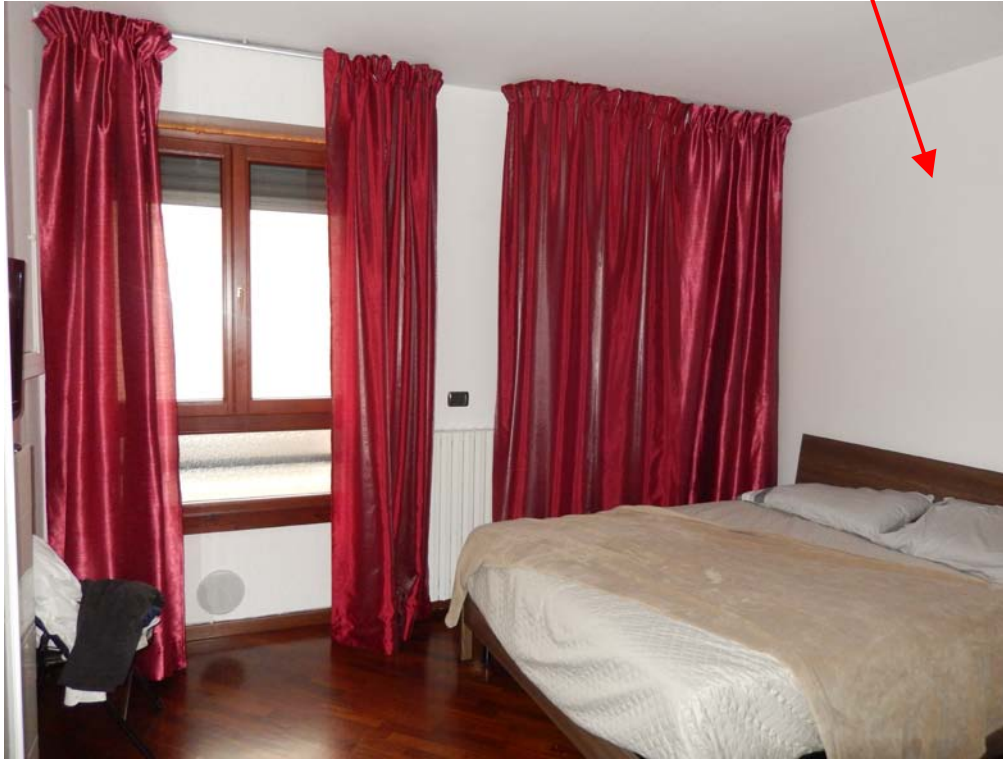
FOTO 16: Interno dell'unità pignorata – Scorcio della camera 1. La parete indicata dalla freccia risulterebbe realizzata senza titolo edilizio.
