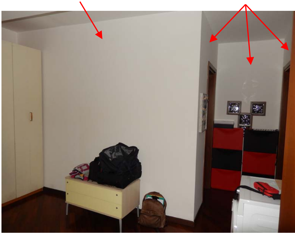
FOTO 13: Interno dell'unità pignorata – Ulteriore scorcio del medesimo locale. Le pareti indicate dalle frecce, che definiscono le due camere, parrebbero edificate senza titolo edilizio (l'impossibilità di accedere agli atti edilizi non consente un esame certo, pertanto il giudizio è derivato dalla sola verifica catastale).
