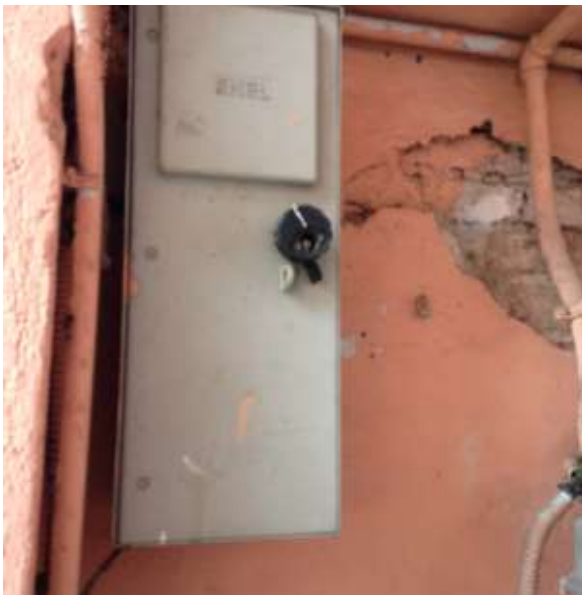
Foto 3. Vista del contatore elettrico.
