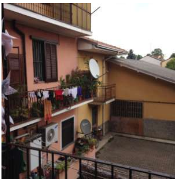
Foto 6. Vista del cortile intero dal ballatoio.
