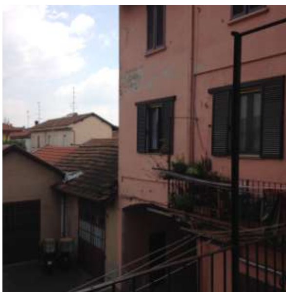
Foto 5. Vista del cortile interno, dal ballatoio.
