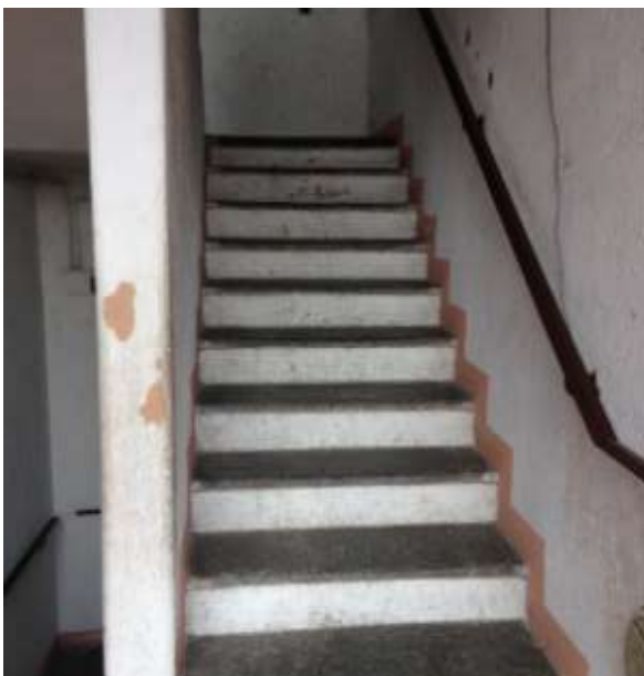
Foto 4. Vista della scala di accesso ai livelli superiori.
