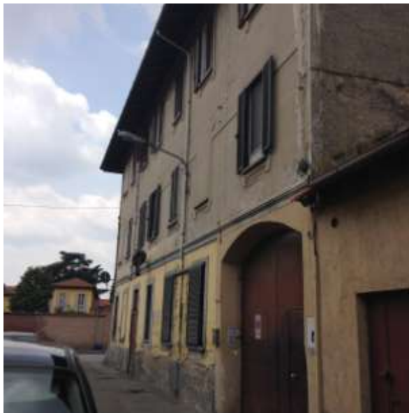
Foto 2. Vista del portone di accesso al fabbricato in ferro.
