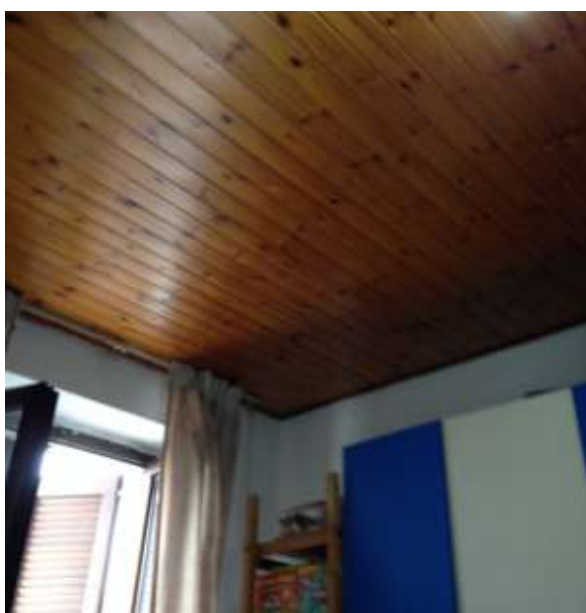
Foto 17. Vista della camera da letto, con soffitto in legno.
