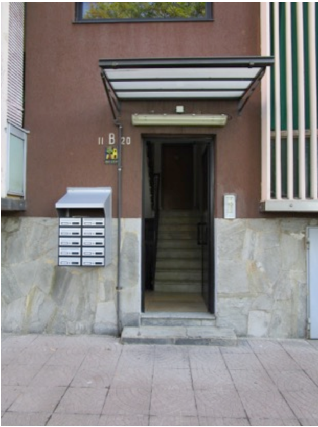
Accesso al fabbricato dal cortile condominiale.
