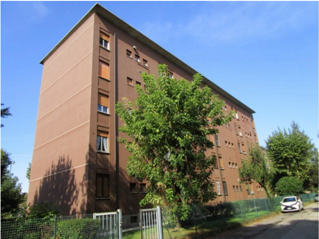
Accesso pedonale al cortile del fabbricato dalla strada privata.
