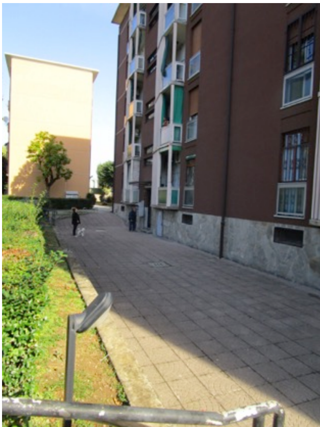
Cortile di fronte al fabbricato, lato ovest.
