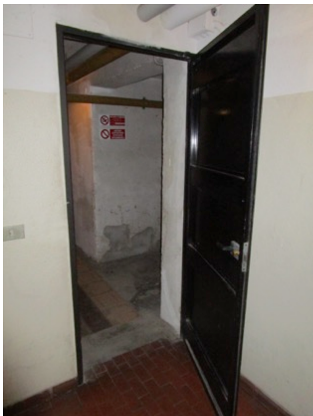
20. Porta di accesso al locale cantine.
