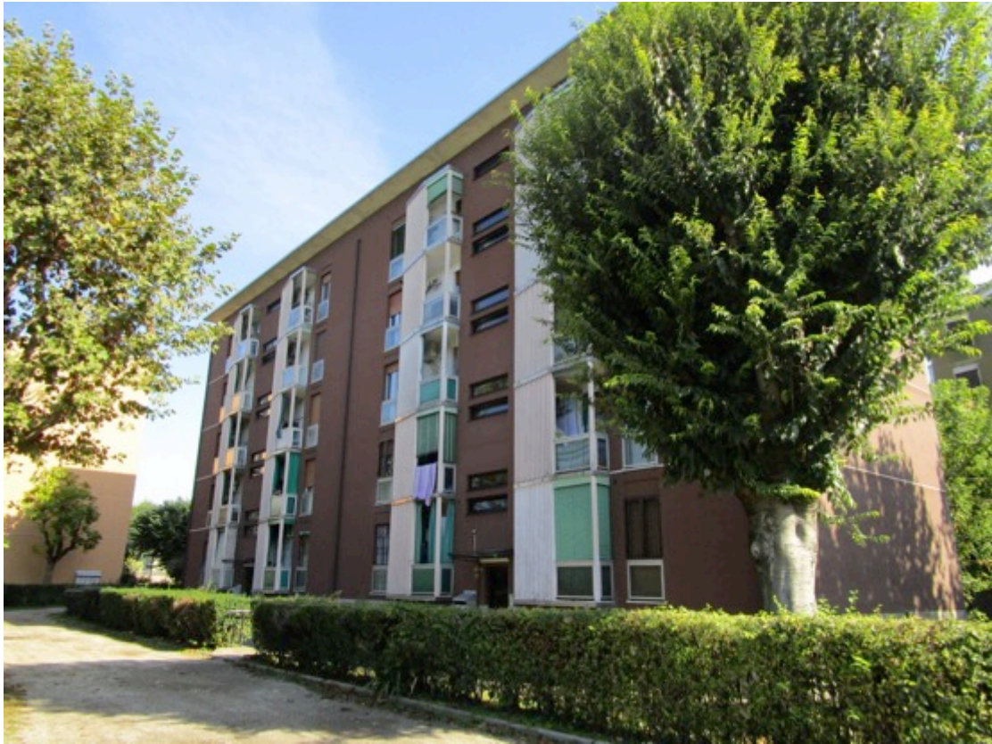
Fabbricato residenziale, vista lato ovest.
