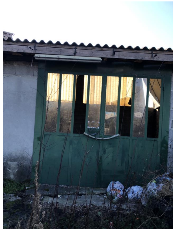
Viste ingresso deposito
