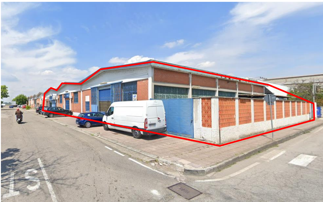
Vista del fabbricato da Via Eching (Google street-view)
