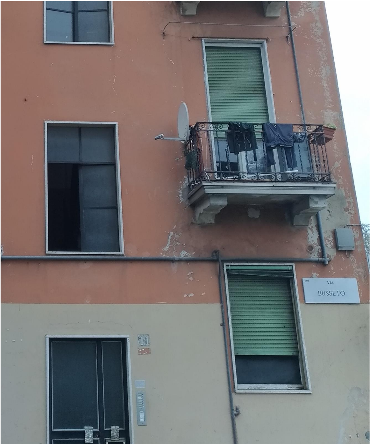
FOTO 4 – PROSPETTO DA VIA BUSSETO, PARTICOLARE BALCONE
