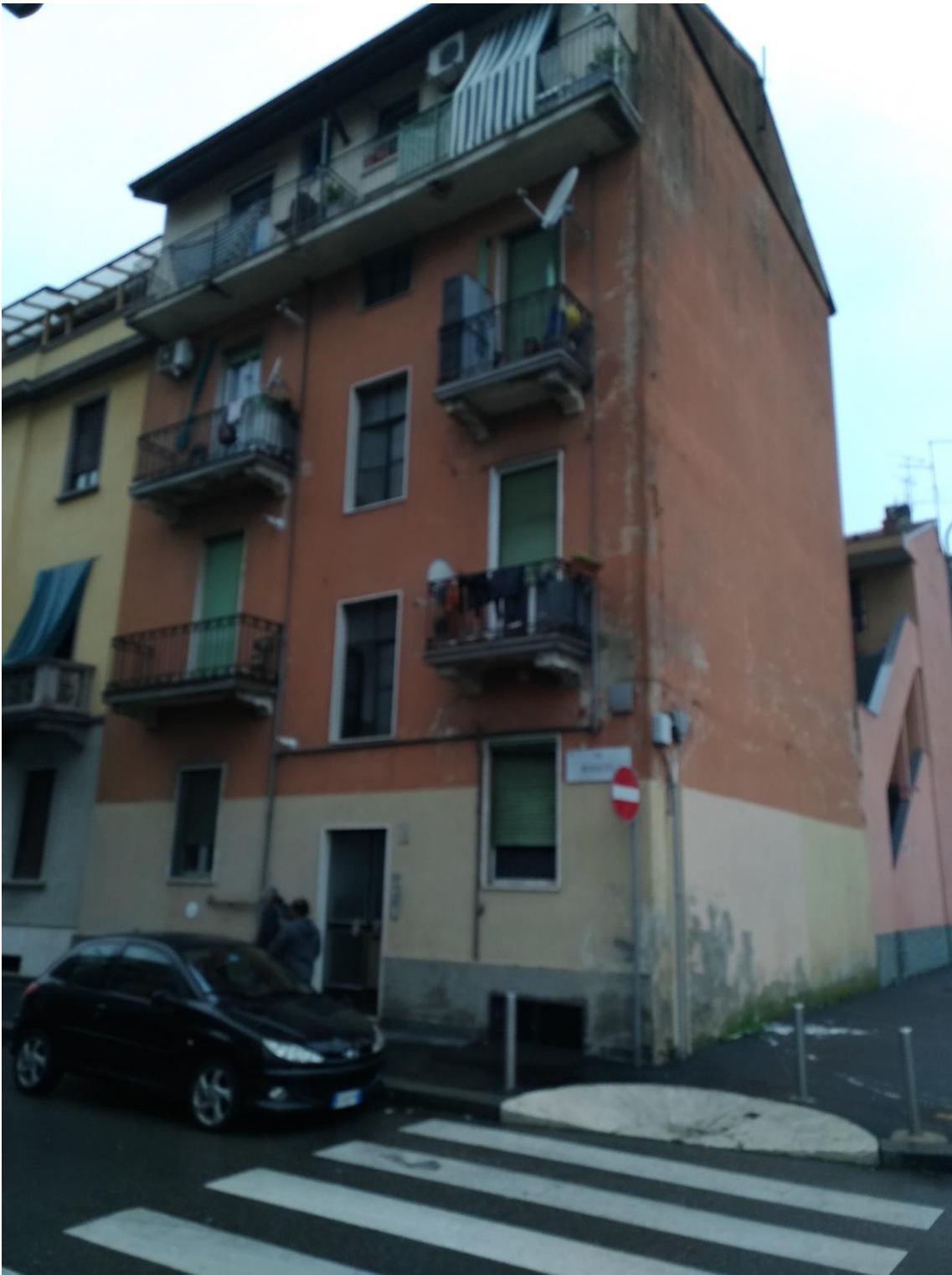
FOTO 1 - PROSPETTO DA VIA BUSSETO ANGOLO VIA 8 OTTOBRE 2001
