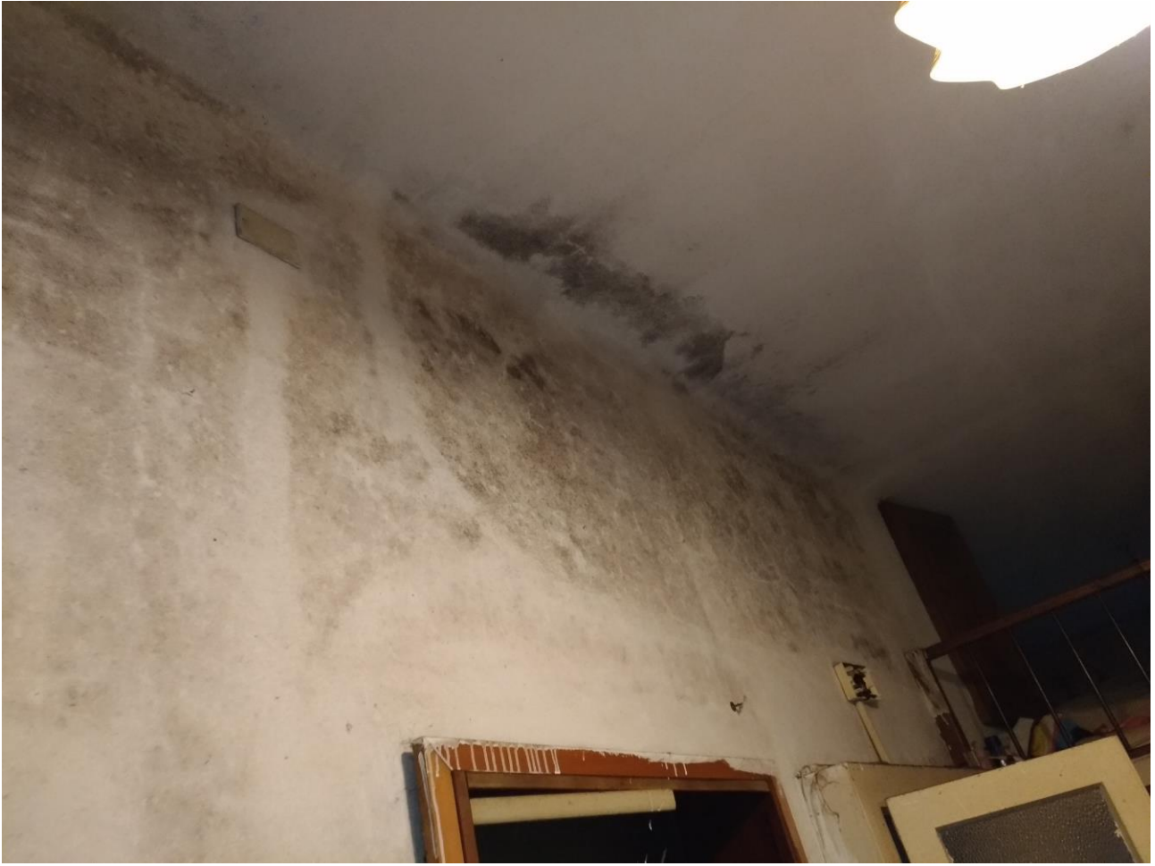
FOTO 10 – INTERNO, PARTICOLARE PARETI PERIMETRALI
