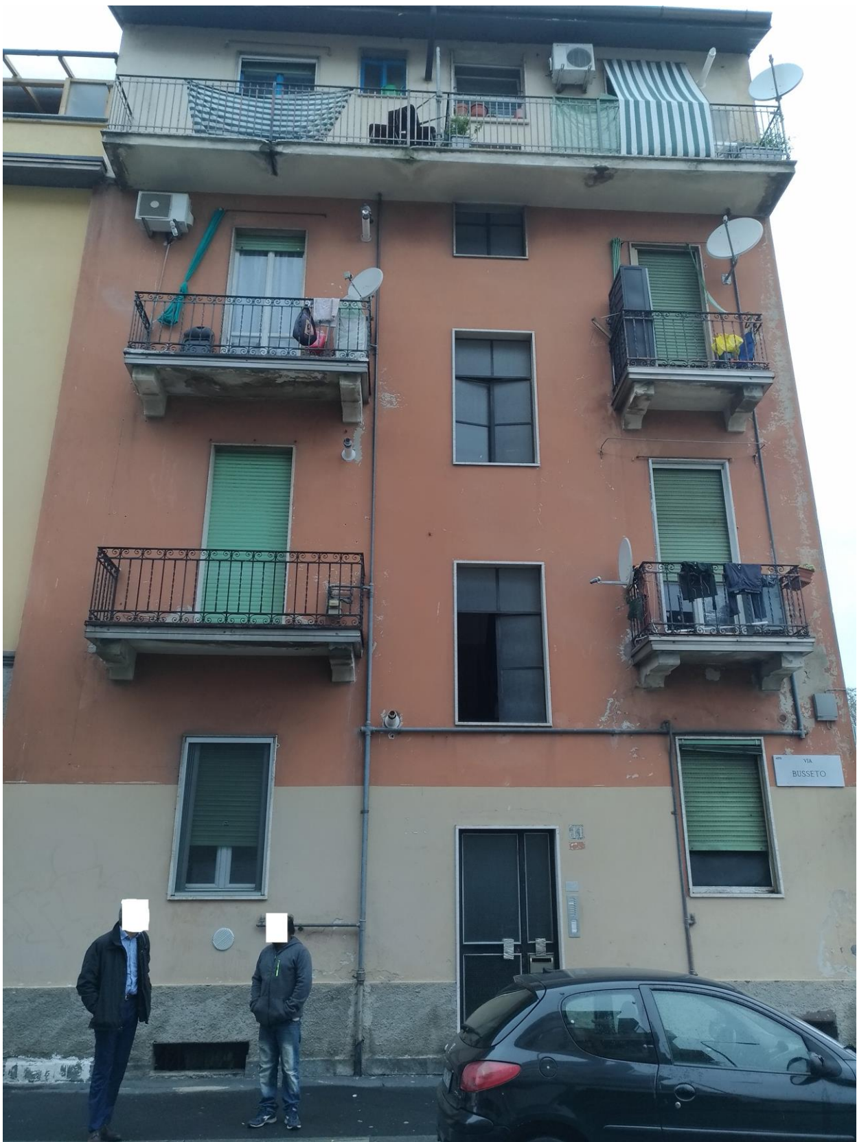
FOTO 2 - PROSPETTO DA VIA BUSSETO
