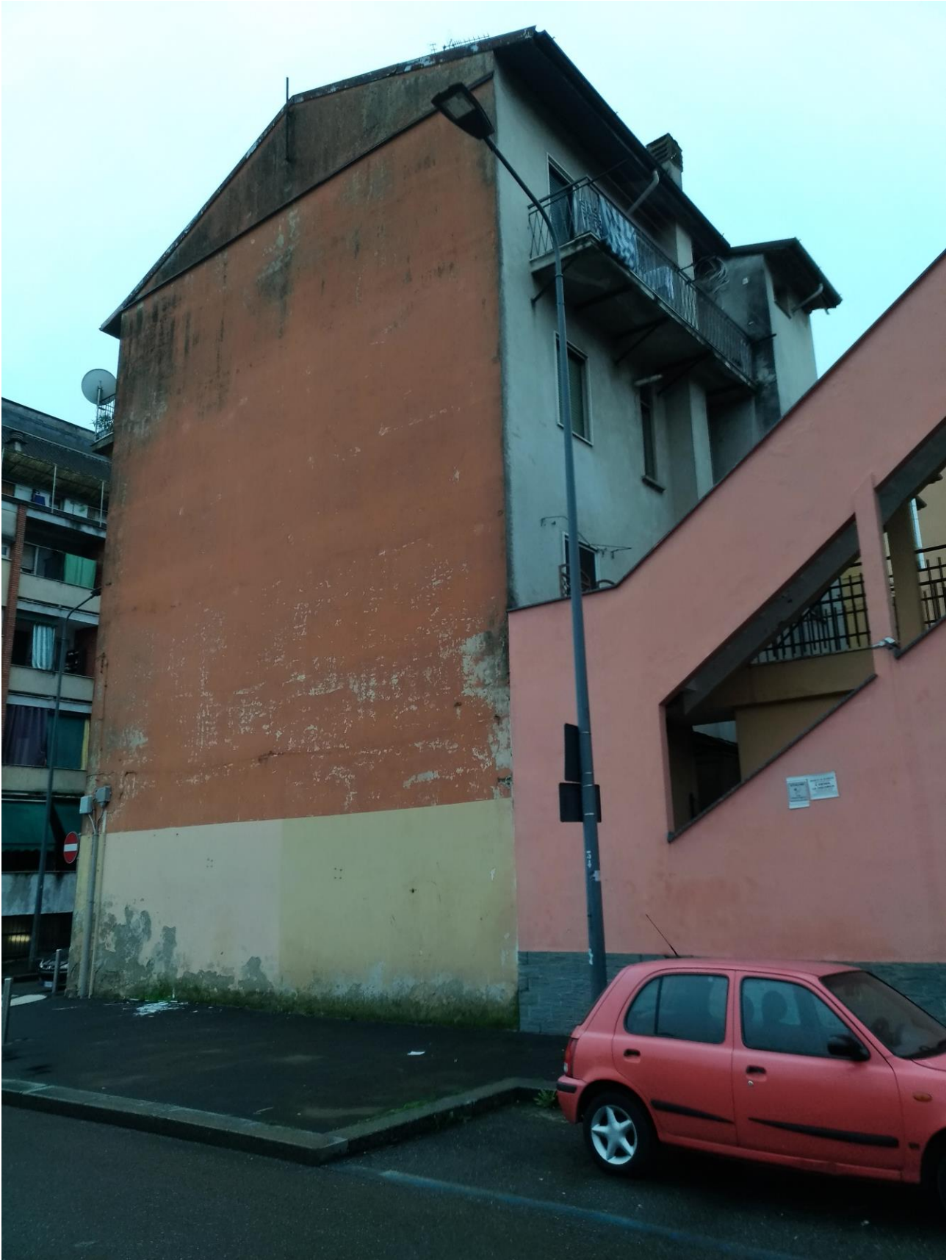
FOTO 3 - PROSPETTO DA VIA 8 OTTOBRE 2001
