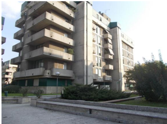
3. Un fabbricato tipo del complesso
