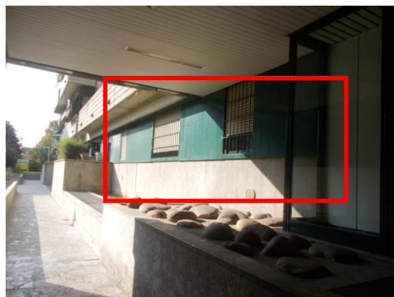
10. Esterno dell'immobile pignorato
