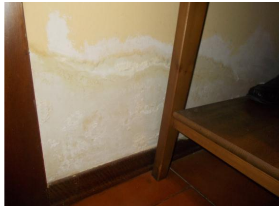
34. Dettaglio muro interno
