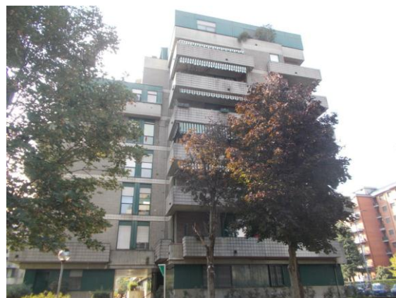
6. Fabbricato all'interno del quale si trova l'immobile oggetto di pignoramento
