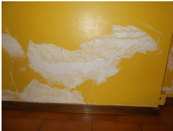
33. Dettaglio muro interno
