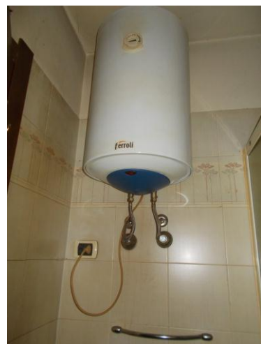
30. Boiler all'interno del bagno
