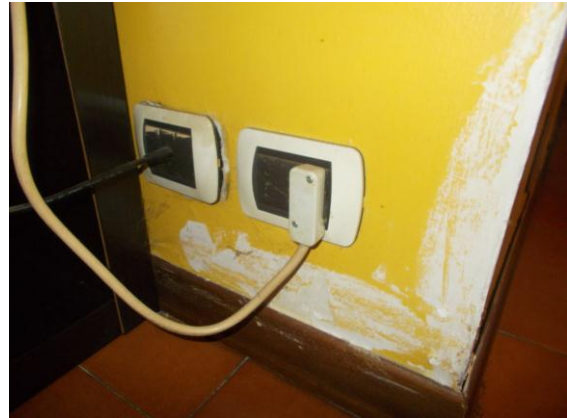
32. Dettaglio presa elettrica
