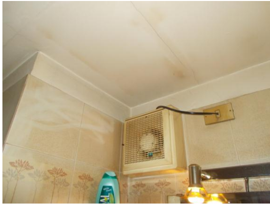
31. Soffitto del bagno
