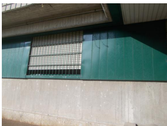
11. Finestra dell'immobile pignorato
