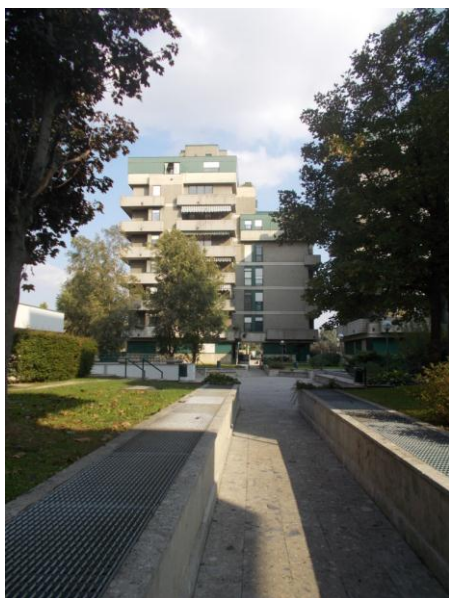
7. Vialetto di ingresso allo stabile
