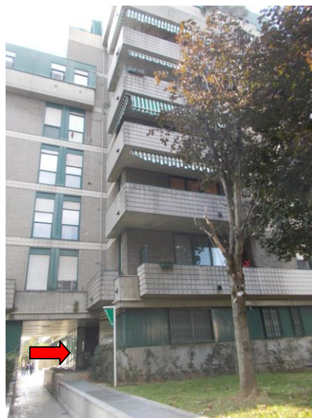
8. Vialetto di ingresso allo stabile
