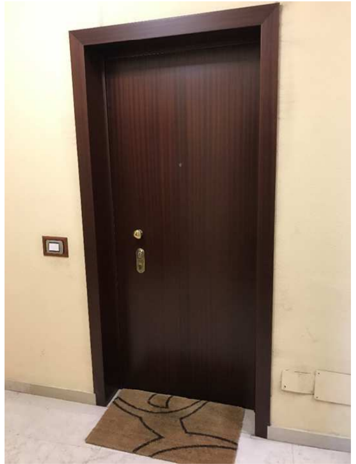
Porta ingresso appartamento
