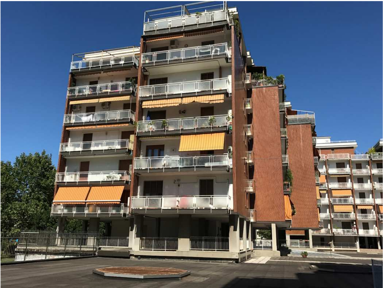
Edificio 11/2 – Fronte EST
