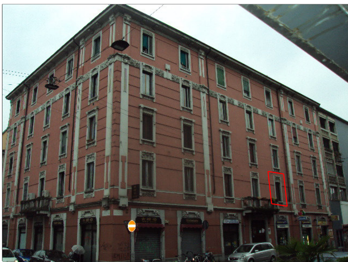
Foto 1 – Prospetto su via Padova
