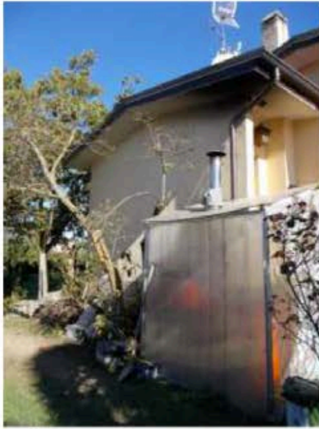
7. Struttura provvisoria nel giardino per ricovero caldaia
