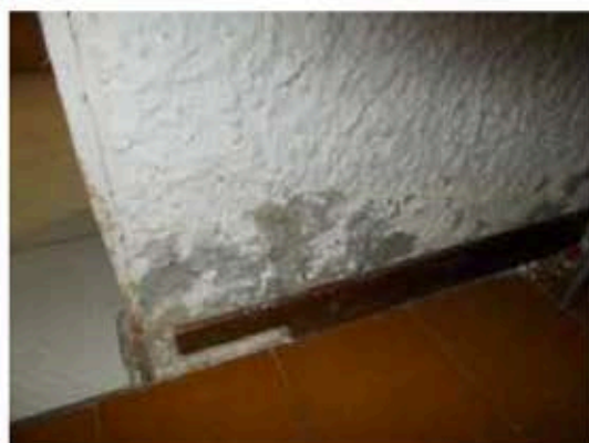
69. Umidità di risalita (taverna)
