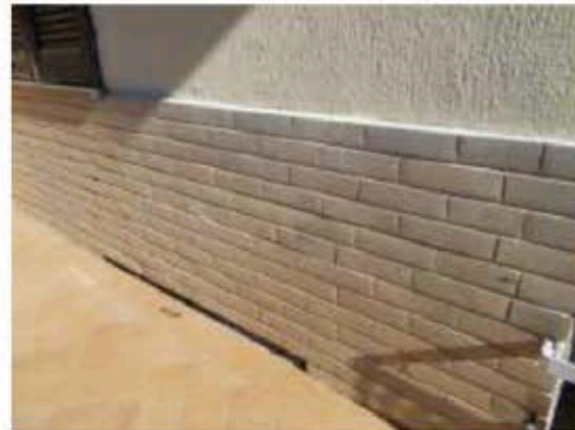
18. Dettaglio zoccolatura della facciata
