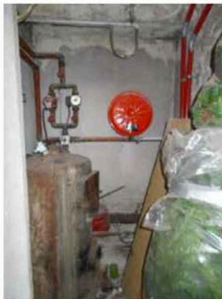
54. Locale caldaia (non in uso)
