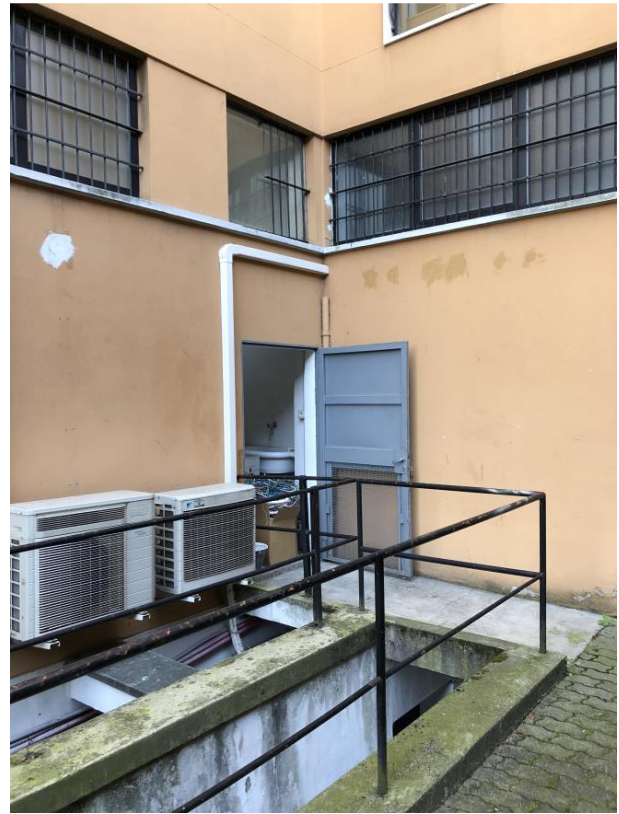
Vista bagno con accesso dal cortile P.T
