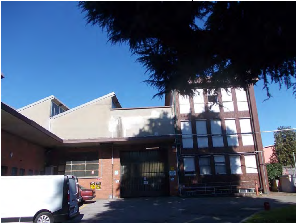
Vista esterni: Palazzina Uffici e Capannone Nord
