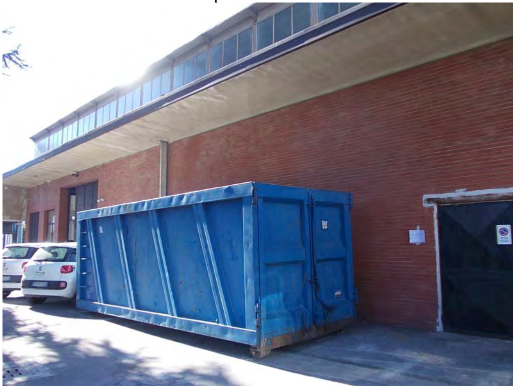
Vista capannone Sud: esterni
