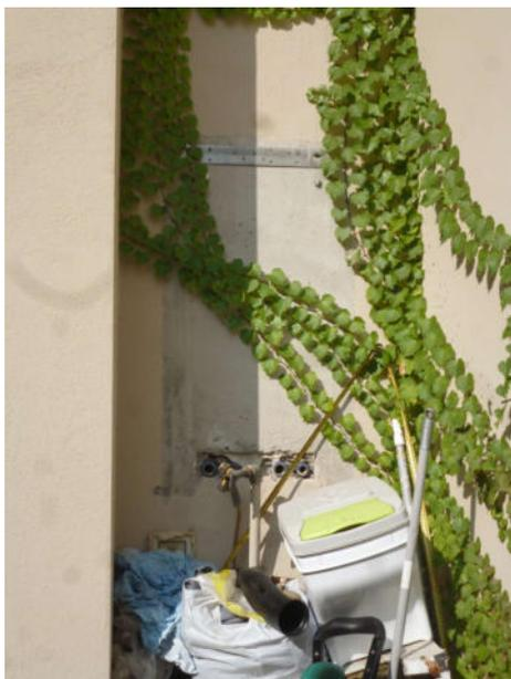
**FOTO 12** – Particolare vano esterno mancante del generatore (caldaia)
