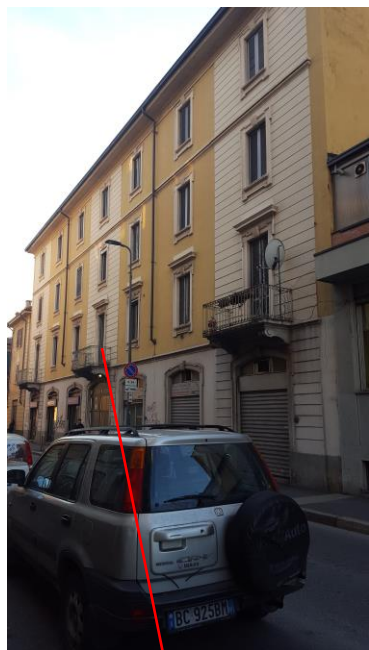
VIA S. FAUSTINO, 3 - FACCIATA
