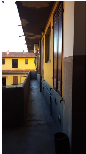
SUB 31 - P4 - BALLATOIO
