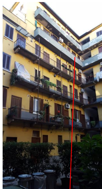
CORPO INTERNO - FACCIATA
