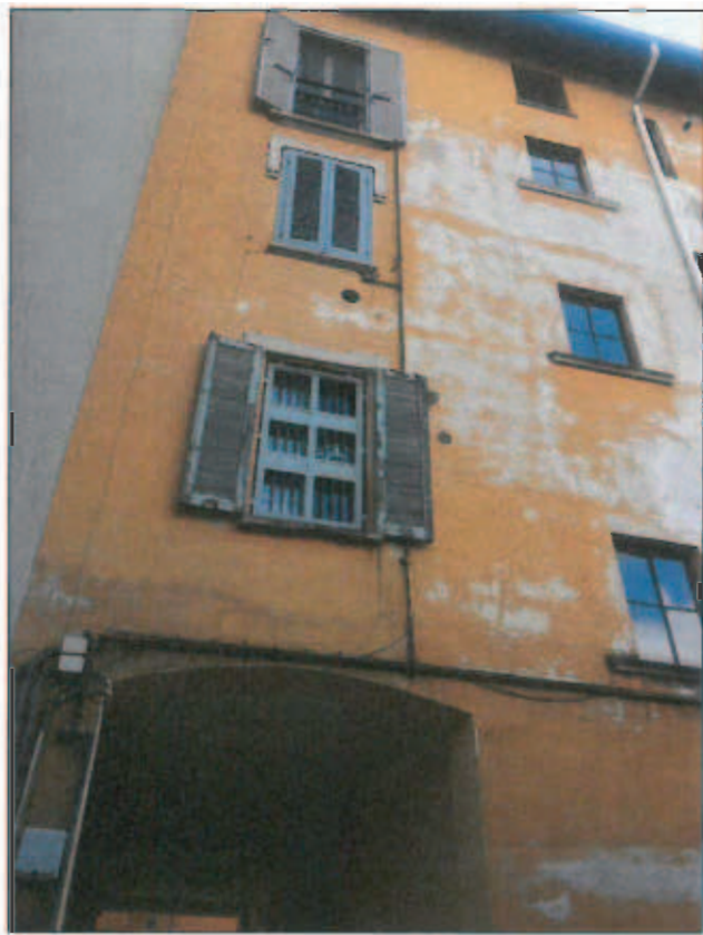
PARTICOLARE PROSPETTO NORD SU SECONDO CORTILE
