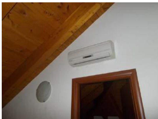
287. Impianto di condizionamento
