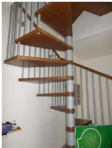
281. Scala di accesso al sottotetto
