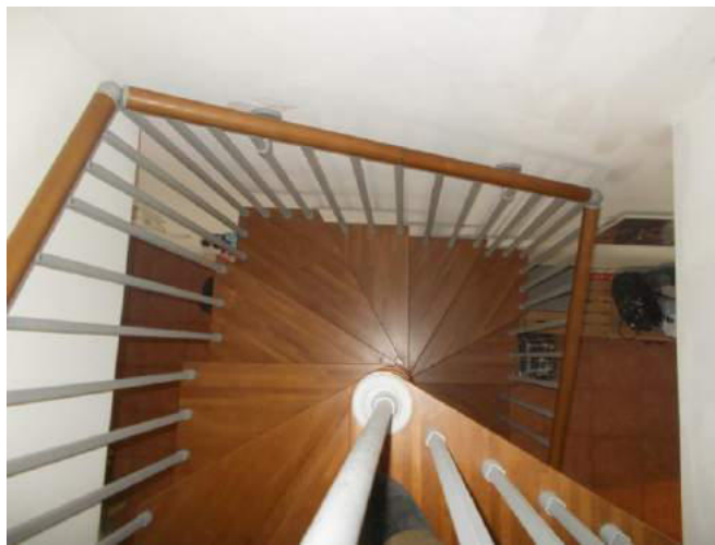
282. Dettaglio della scala
