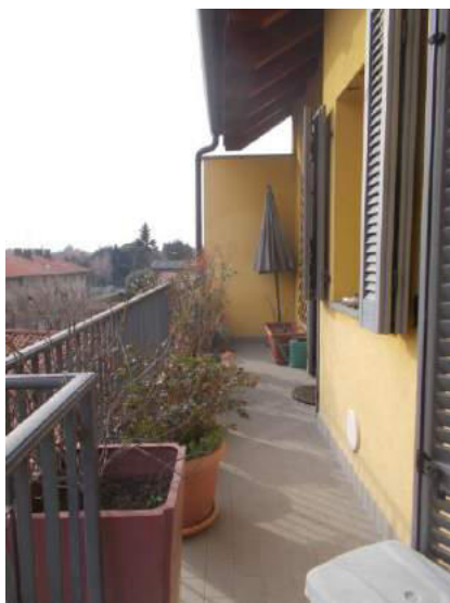
333. Balcone in lato sud sul cortile
