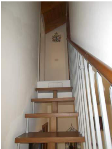
347. Scala di accesso al sottotetto
