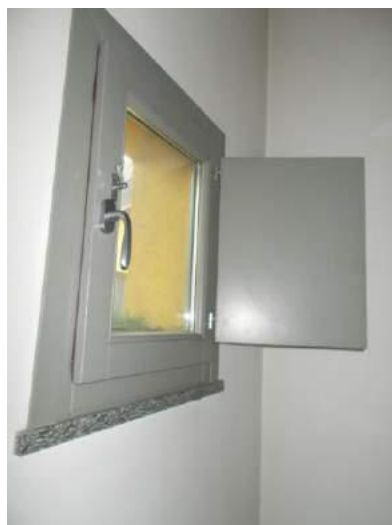
116. Dettaglio della finestra
