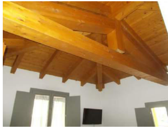
130. Soffitto camera al piano 3
