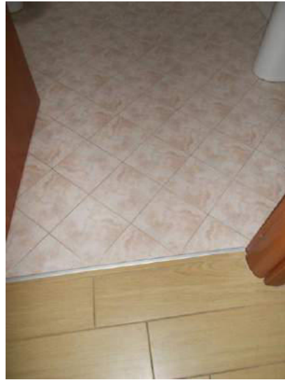
126. Dettaglio della pavimentazione
