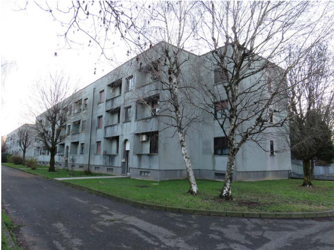
FACCIATA SU AREA A VERDE
