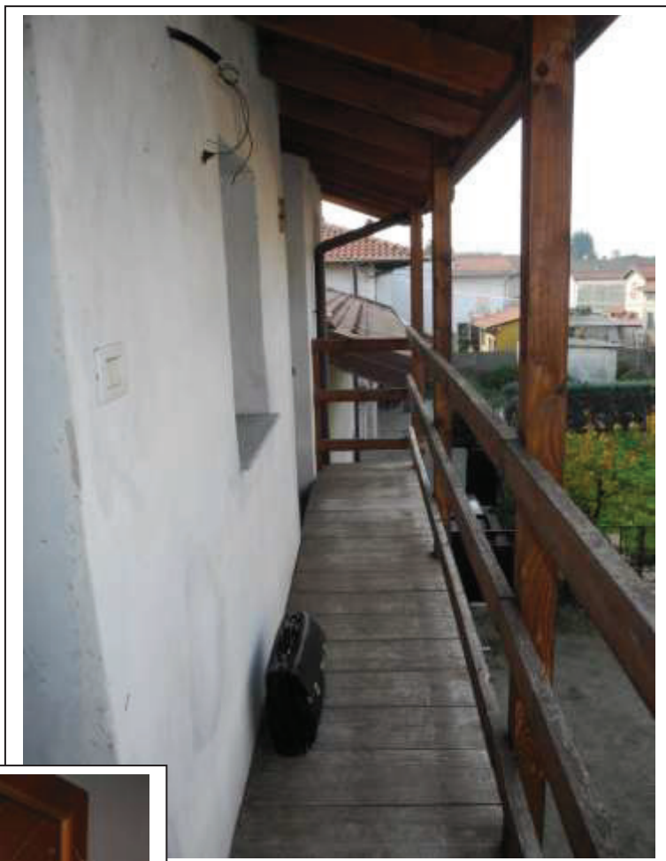
Fotografia n°11 – Vista del ballatoio comune in legno al secondo piano.
