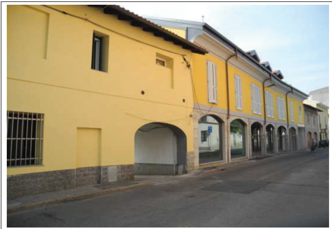
Fotografia n°1 – Vista del fabbricato fronte strada da cui si accede ai cortili interni ove è ubicata la porzione immobiliare in oggetto – al centro si osserva l’androne carraio.
