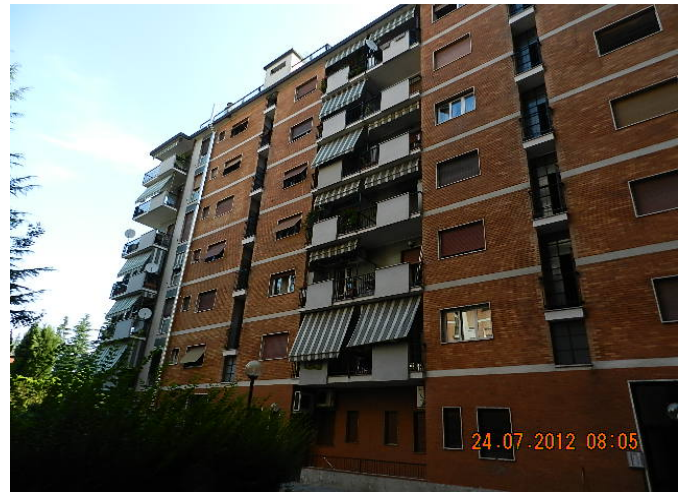
Facciata su cortile
