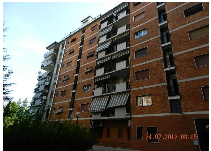
Facciata su cortile
