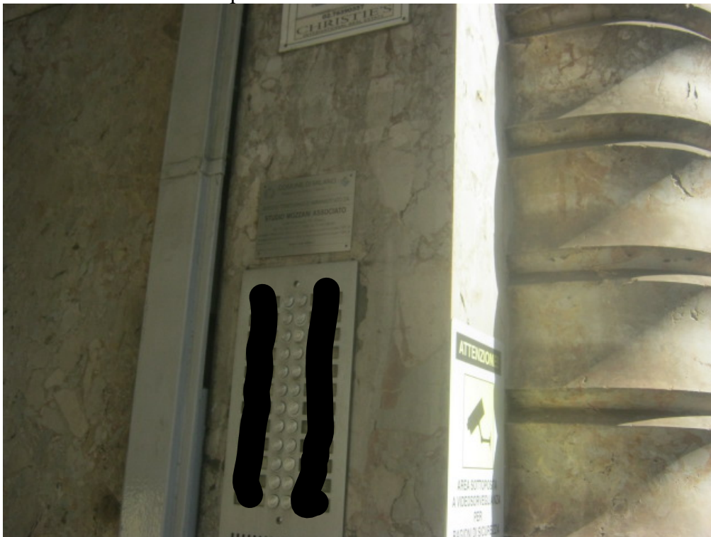
impianto citofonico condominiale
