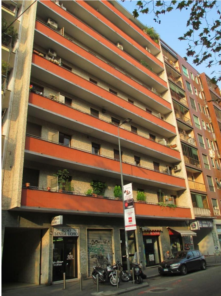
Foto 1: edificio viale Carlo Troya 8/A – Milano – fronte strada
