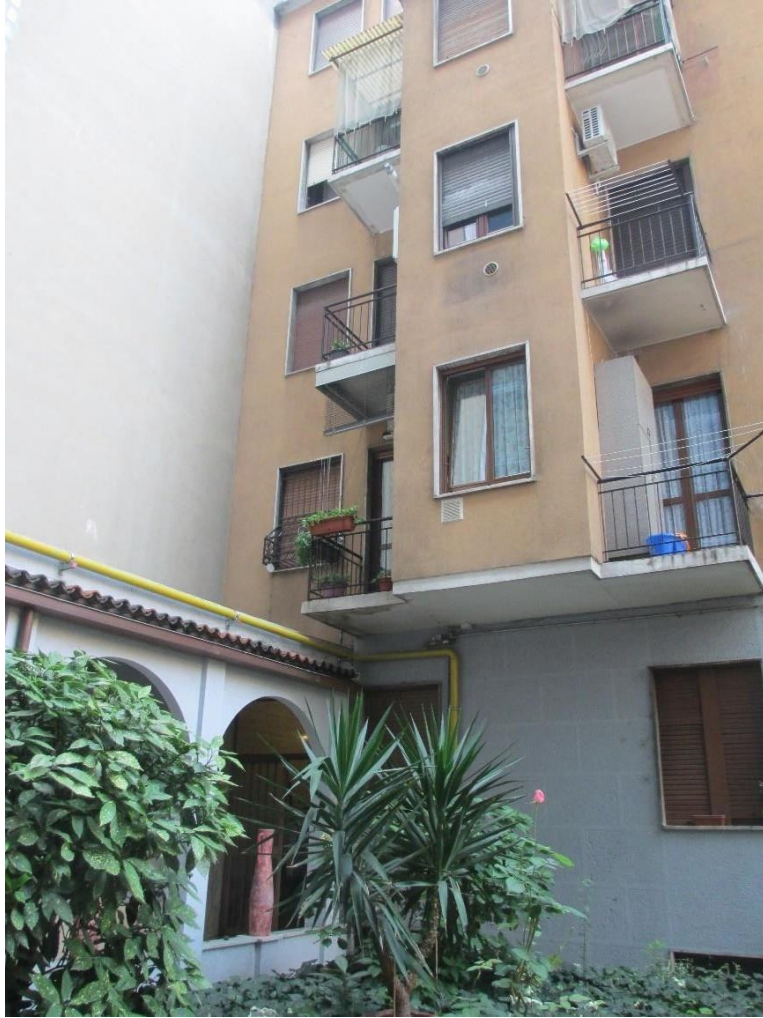
Foto 2: edificio interno in cui è ubicato l'immobile.
