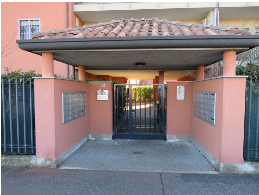
PORTONCINO INGRESSO AL COMPLESSO IMMOBILIARE
