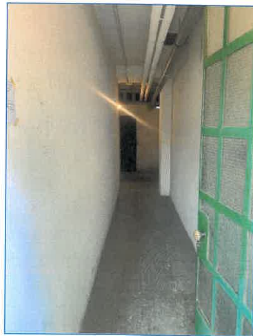
Foto 12 - ingresso comune piano cantine
