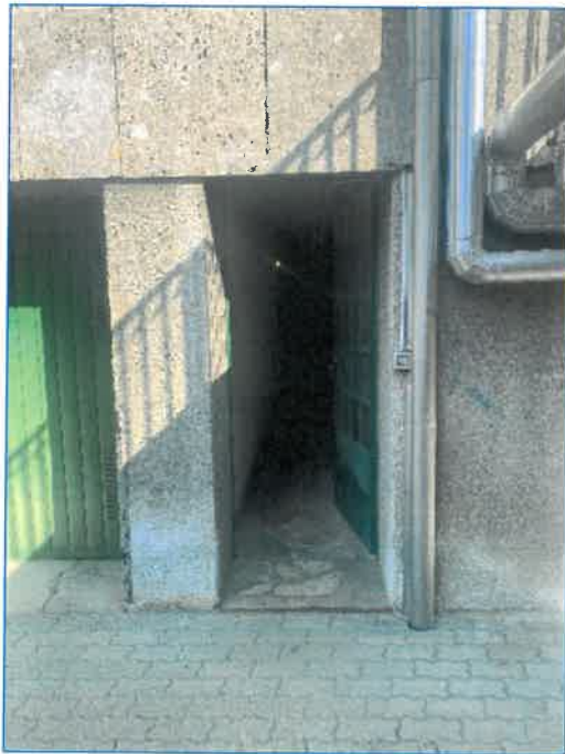
Foto 11 - ingresso comune piano cantine
