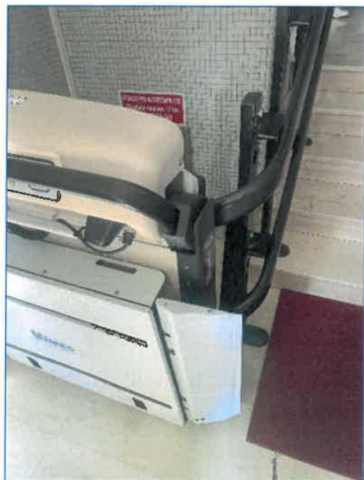
Foto 7 - vano scala comune
