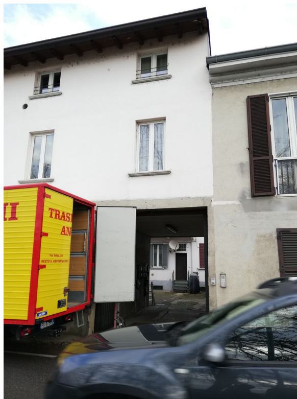
Accesso al cortile da via Cusago
