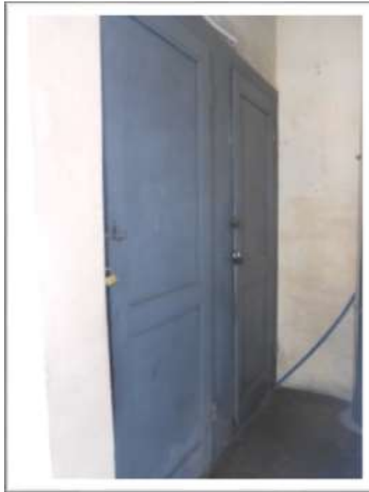
Foto 17 porta ingresso al wc esterno
