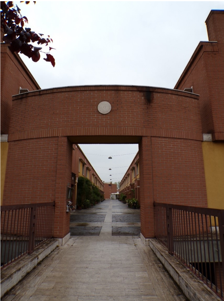
Foto 1: esterno – accesso zona condominiale non interdetta
