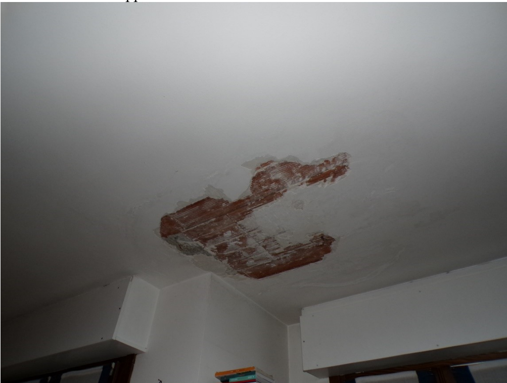
Foto 13: infiltrazioni dal soffitto
