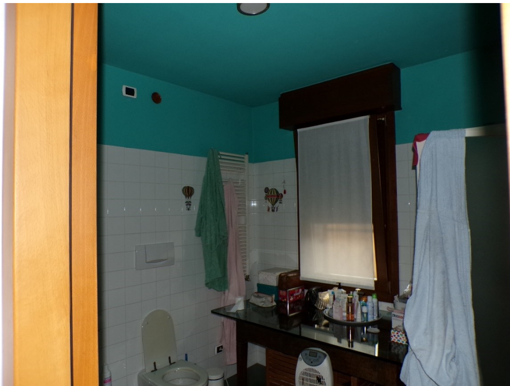
Foto 7: bagno piano primo
