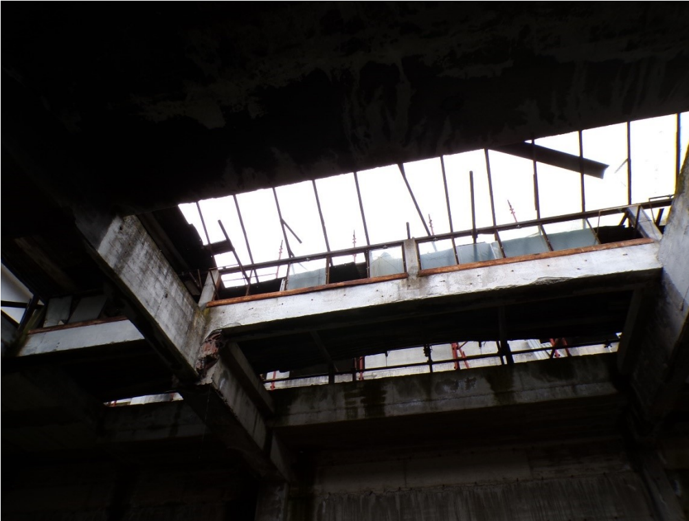
Foto 7: Corpo A sub. 8 – magazzino con problemi infiltrazioni gravi
