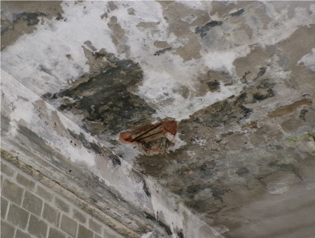
Foto 5: Corpo A sub. 8 – magazzino con problemi infiltrazioni gravi
