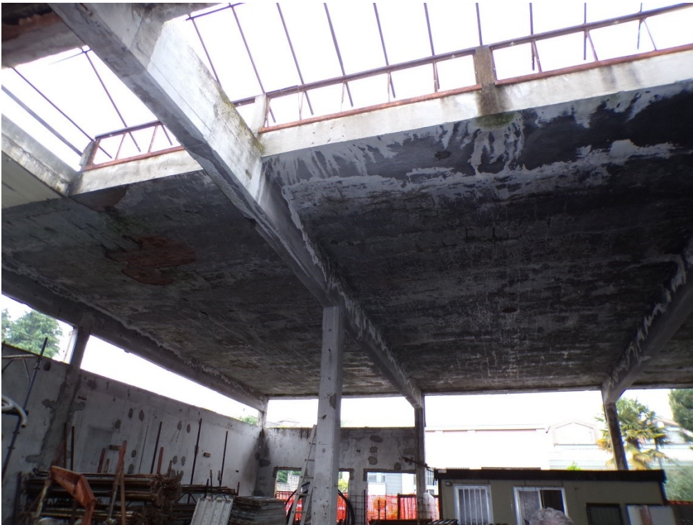
Foto 3: Corpo A sub. 8 – magazzino con problemi infiltrazioni gravi
