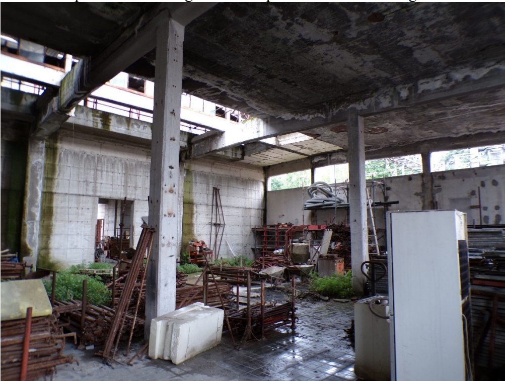
Foto 6: Corpo A sub. 8 – magazzino con problemi infiltrazioni gravi
