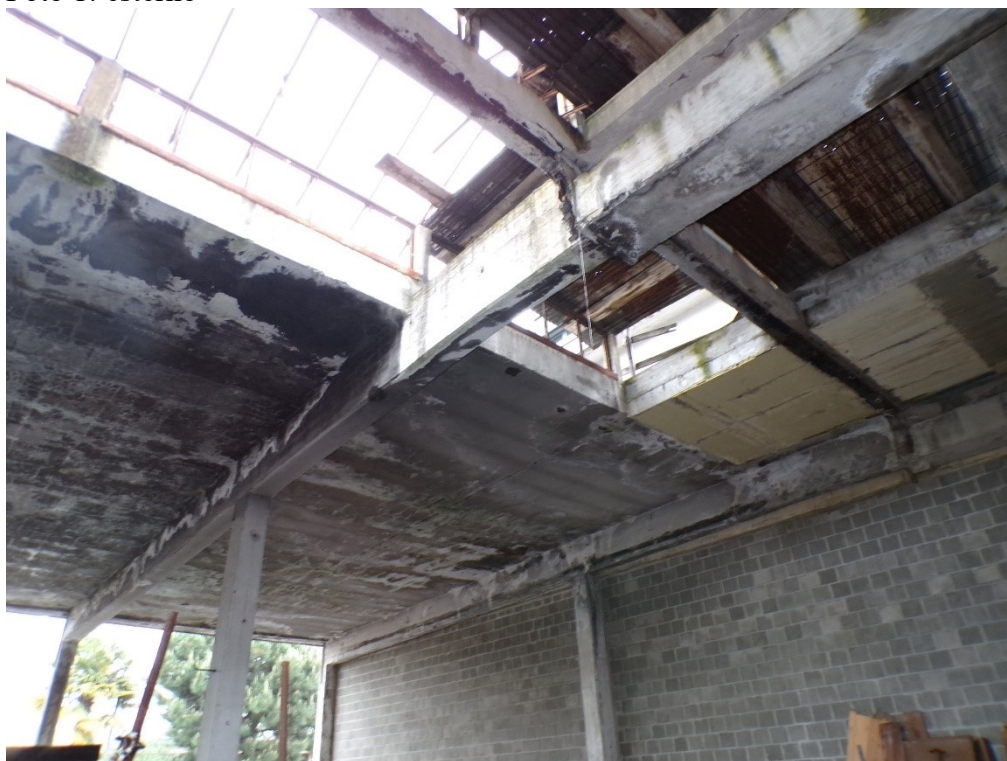
Foto 2: Corpo A sub. 8 – magazzino con problemi infiltrazioni gravi
