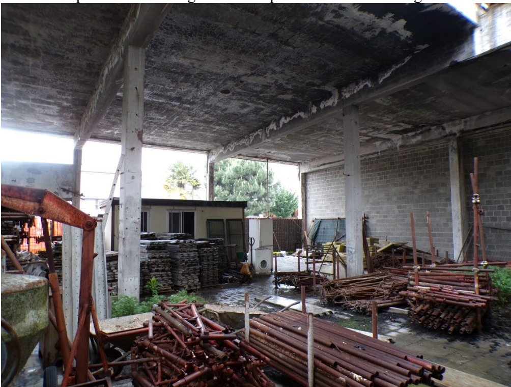
Foto 4: Corpo A sub. 8 – magazzino con problemi infiltrazioni gravi
