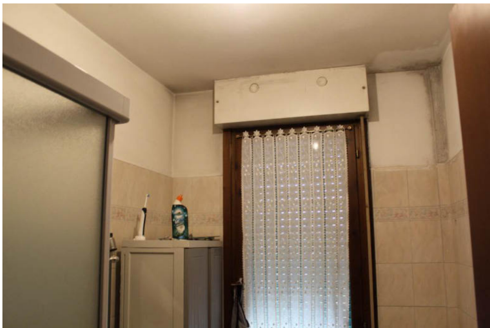
FOTO 13: TREZZANO ROSA, VIA VERDI 10, bagno
