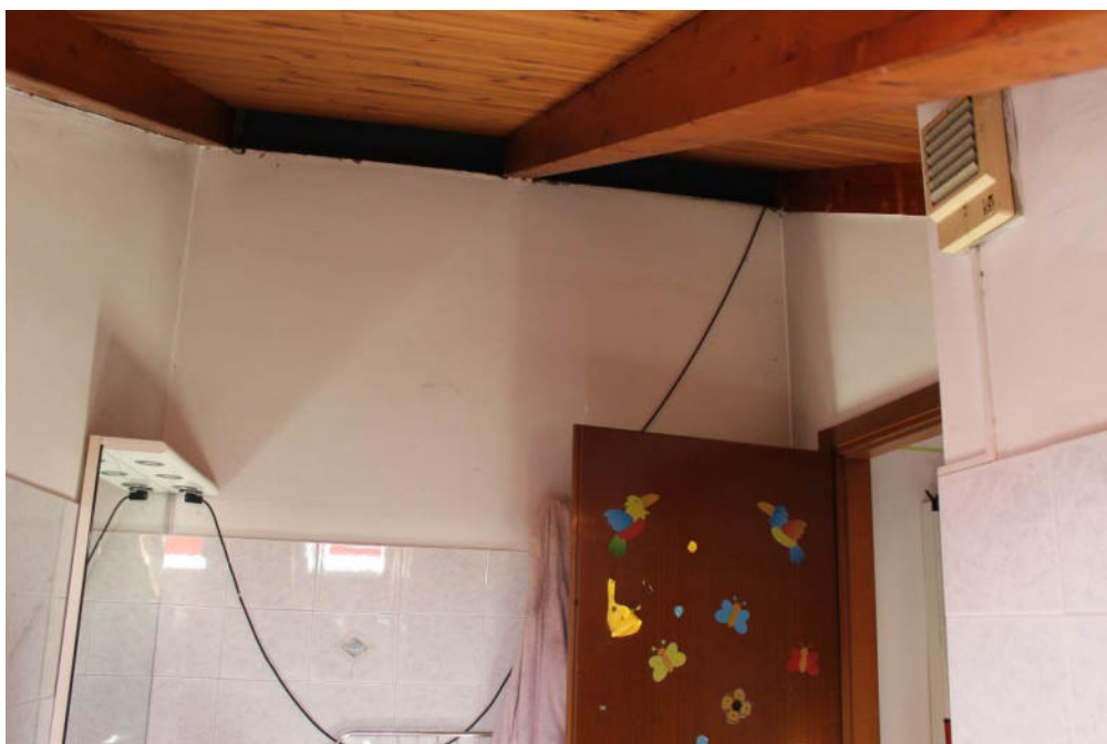
FOTO 21: TREZZANO ROSA, VIA VERDI 10, bagno della soffitta
