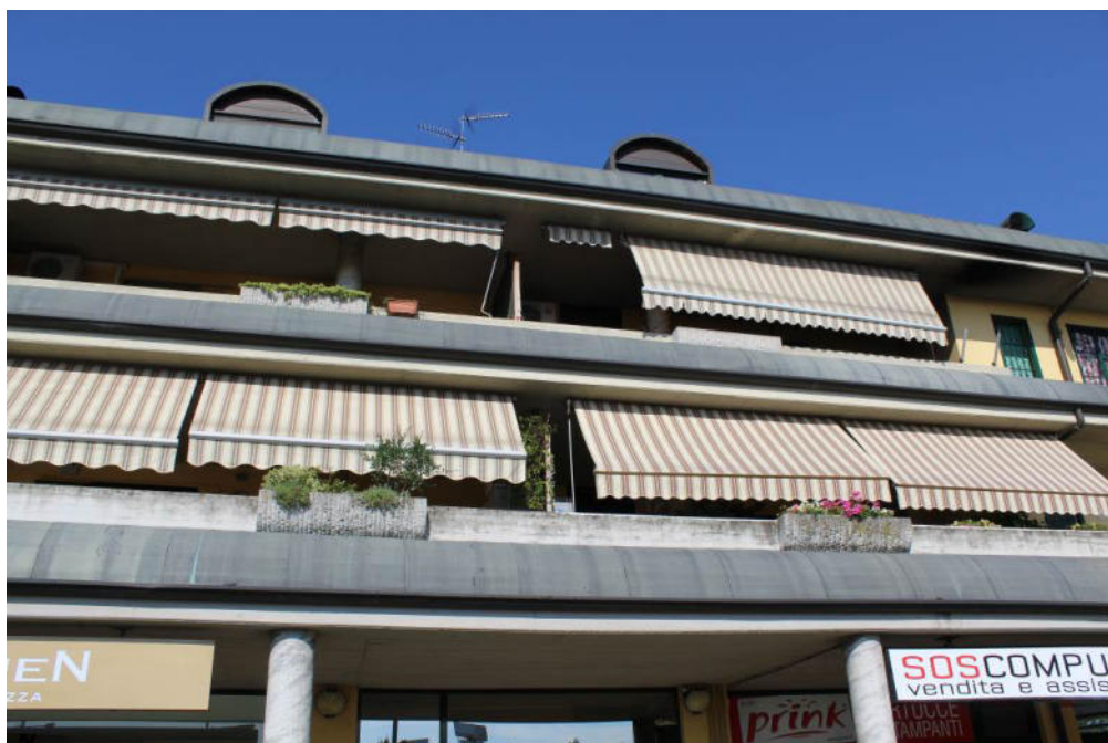
FOTO 2: TREZZANO ROSA, VIA VERDI 10, fronte edificio
