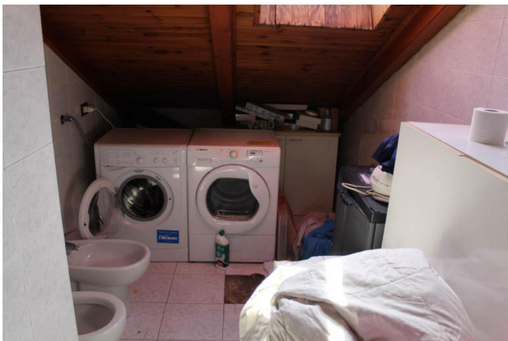
FOTO 24: TREZZANO ROSA, VIA VERDI 10, bagno della soffitta
