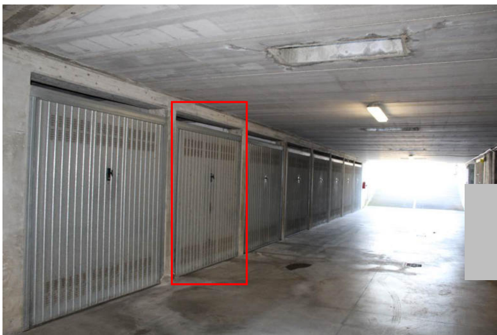
FOTO 25: TREZZANO ROSA, VIA VERDI 10, corsello comune e box
