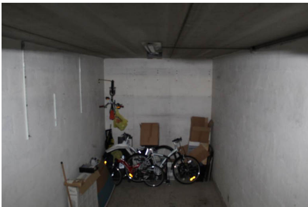
FOTO 26: TREZZANO ROSA, VIA VERDI 10, interno box
