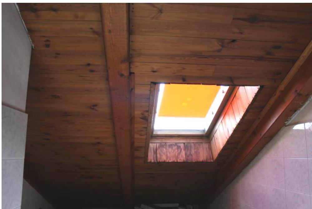
FOTO 23: TREZZANO ROSA, VIA VERDI 10, plafone bagno della soffitta
